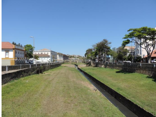
Foto 14 - Vista atual das Avenidas Hermílio Alves (à esquerda da foto) e Tancredo Neves (à direita)
