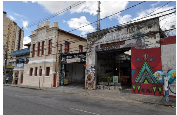
Figura 18 – Benfeitoria e, ao lado, Sobrado restaurado.
