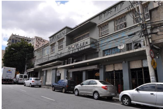
Figura 13 – Salumeria Central e Pacatore no pavimento térreo da edificação.
