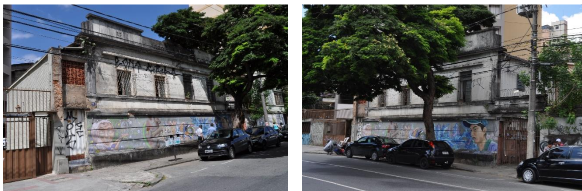
Figura 4 – Fachada frontal da principal edificação da antiga Vila Bracarense, voltada para a rua.
