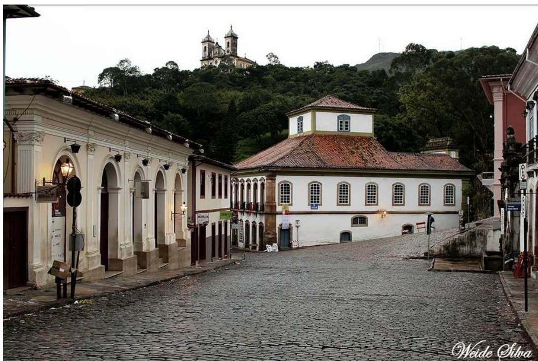
Figura 17 – Vista do Largo do Cinema. Detalhes das alterações no edifício do Cine Vila Rica, antigo Liceu de Artes e Ofícios
