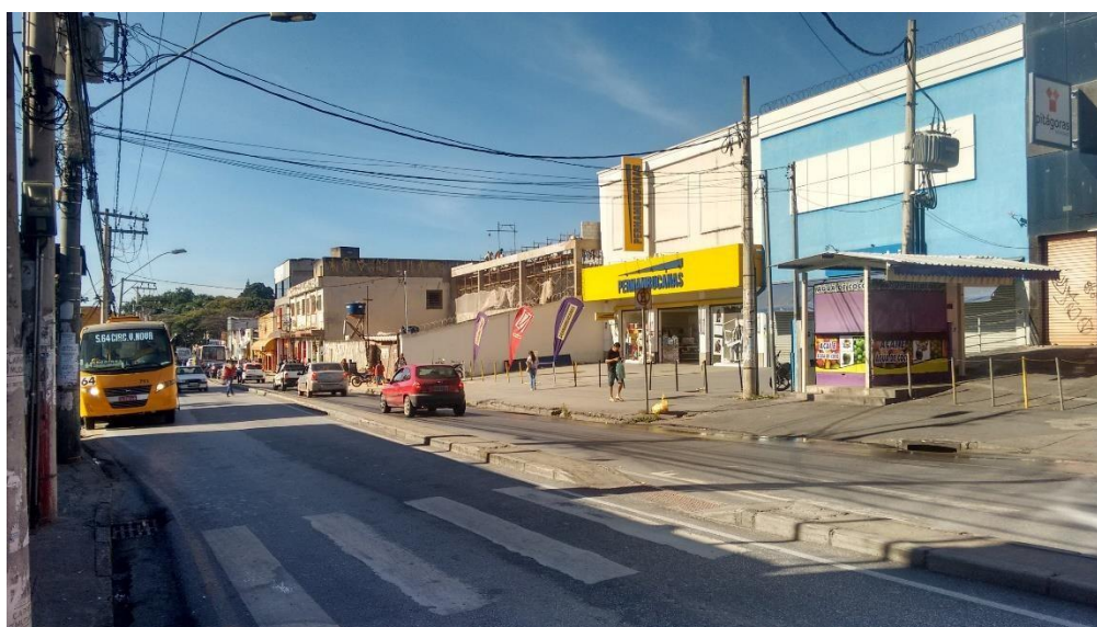
Figura 17 - Tipologias das edificações da Rua Padre Pedro Pinto.
