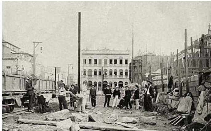
Figura 41 – Reforma de Pereira Passos: demolições para construção da Av. Central, Rio de Janeiro, 1904 – 1905.
