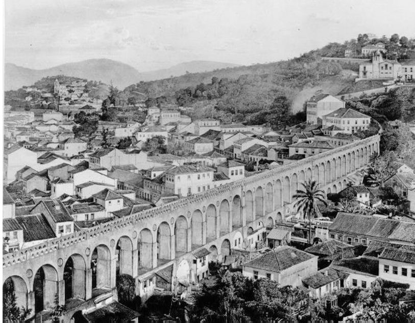
Figura 38 – O aqueduto da carioca e o Morro de Santa Teresa, Rio de Janeiro, 1858.
