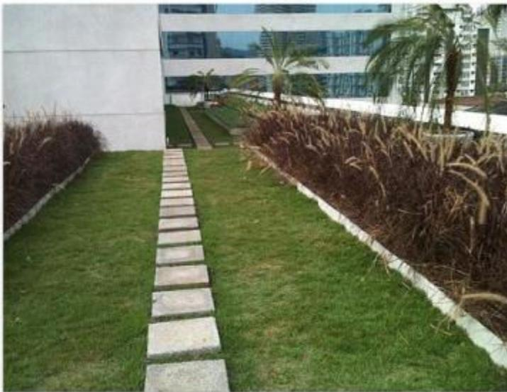
Figura 14 – Telhado verde intensivo.
