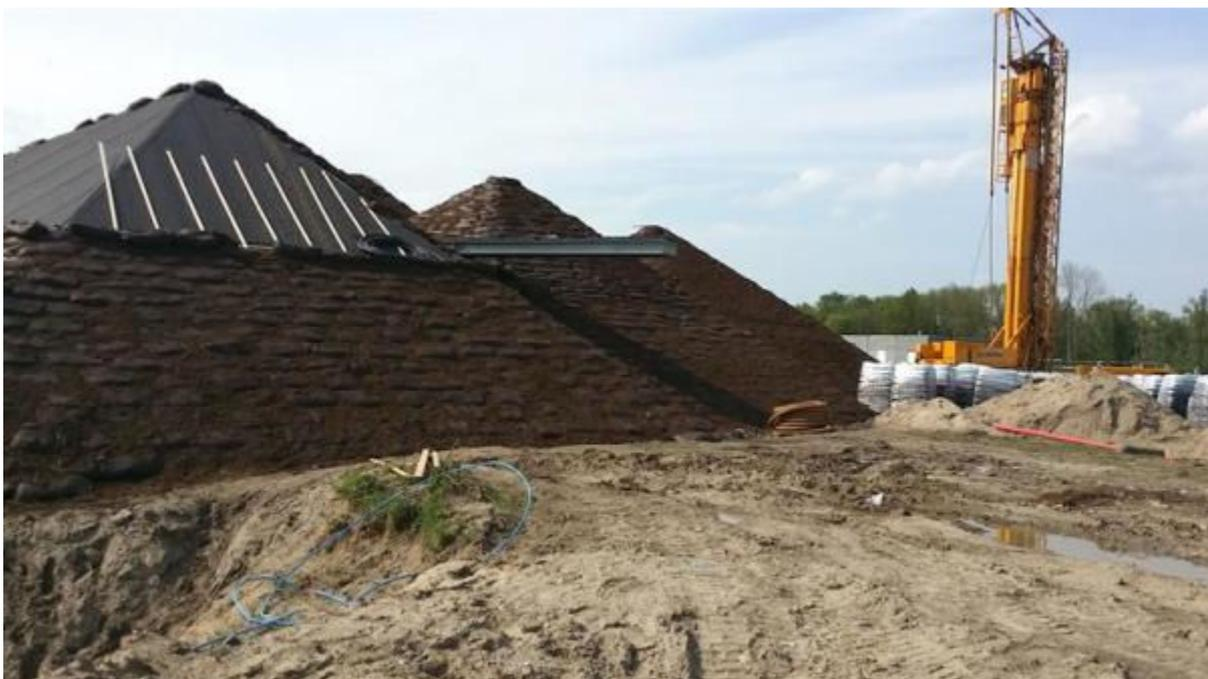
Figura 49 – Substrato e impermeabilização do telhado do novo pavilhão.
