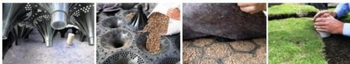
Figura 16 – Passo a passo da montagem do sistema laminar alto.
