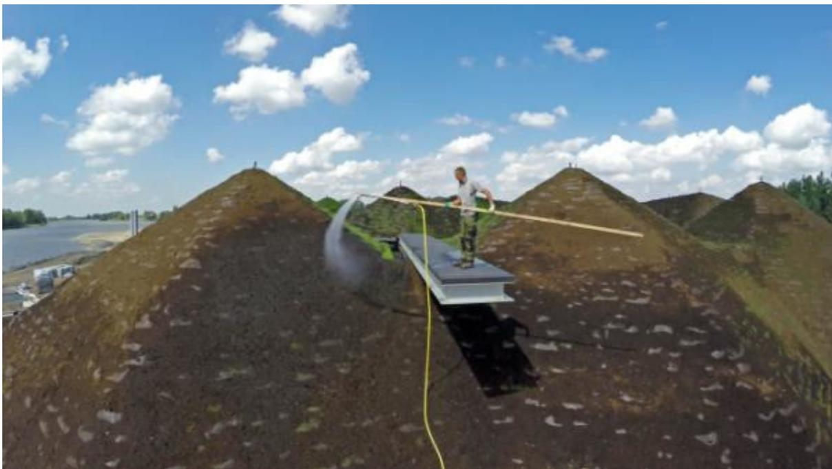
Figura 46 – Preparação do substrato do telhado do novo pavilhão.
