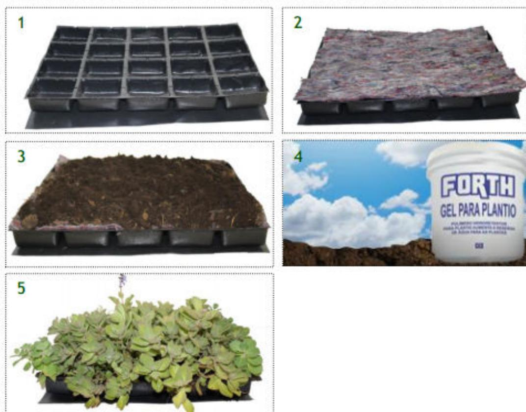
Figura 32 – Passo a passo para instalação do sistema alveolar leve.
