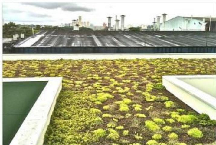
Figura 10 – Telhado verde extensivo.
