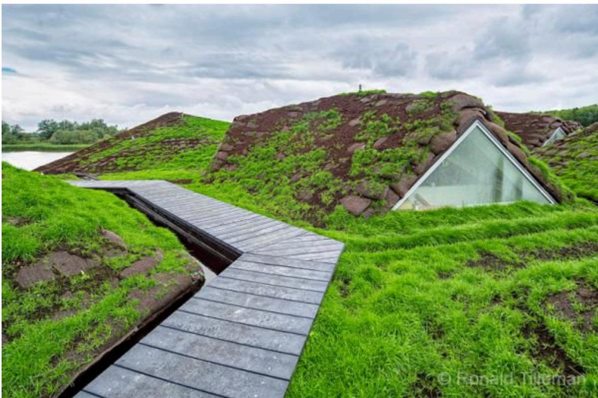
Figura 51 – Gramas são plantadas no telhado do novo pavilhão.
