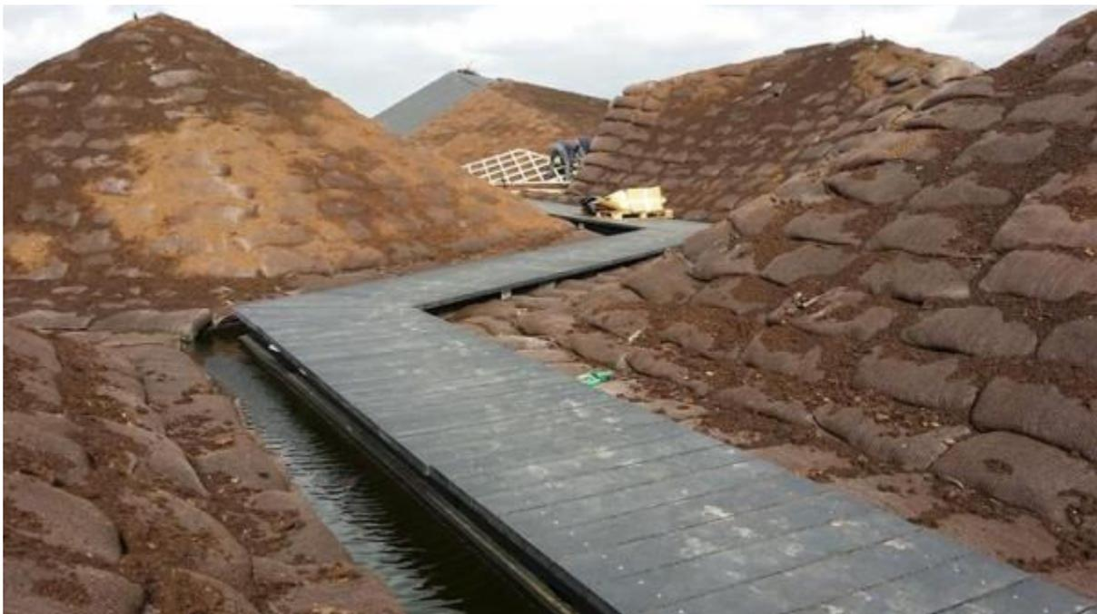
Figura 48 – Preparação do substrato do telhado do novo pavilhão.
