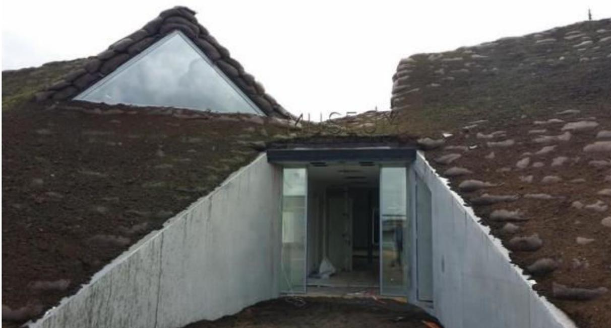
Figura 50 – Preparação do substrato do telhado do novo pavilhão.
