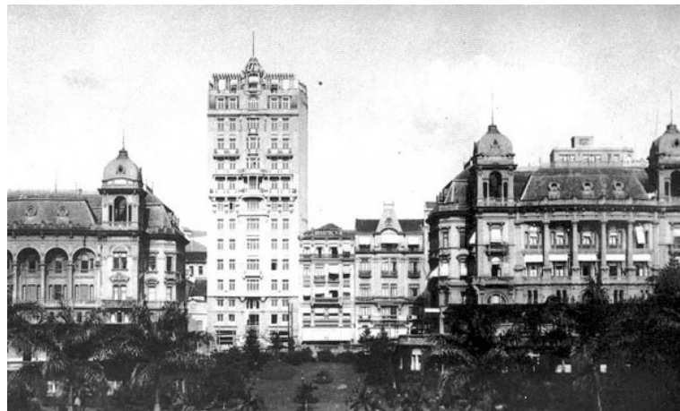
Fig.2.9: Christiano Stockler - Edifício Sampaio Correia (1924), São Paulo
