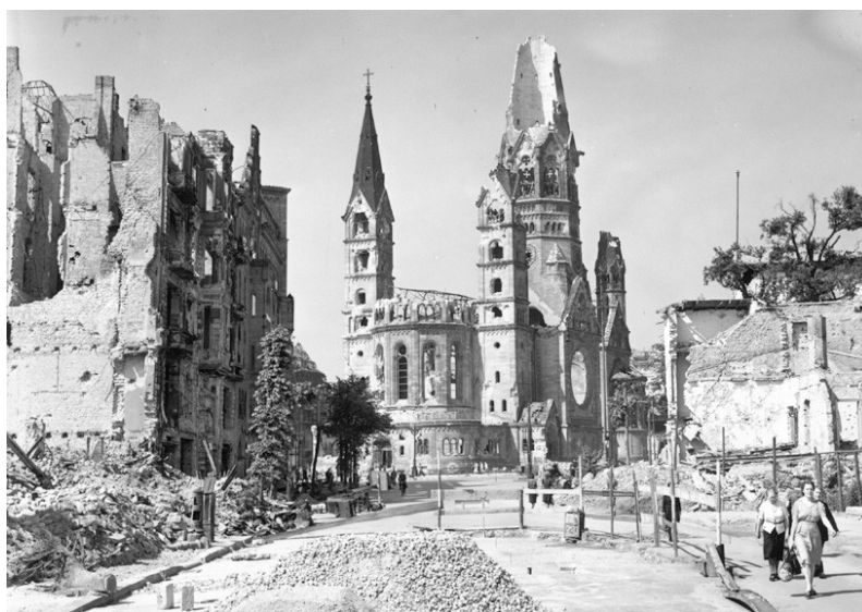
Fig.4.17: Ruínas da Igreja após bombardeios de 1943
