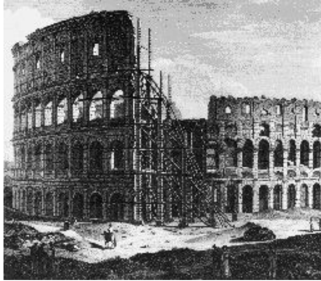
Fig.1.29: Ilustração andaime para construção do contraforte
