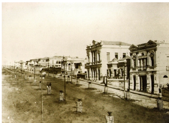
Fig.A.16: Avenida João Pinheiro início do século XX
