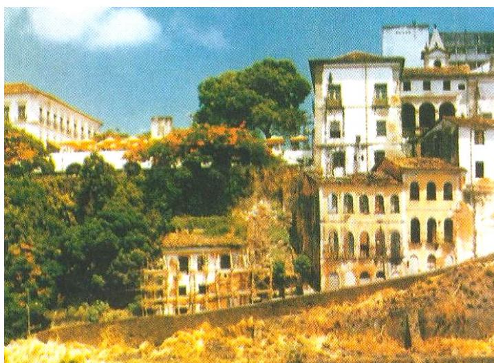
Fig.A.9: Lina Bo Bardi - Ladeira da Misericórdia antes da restauração
