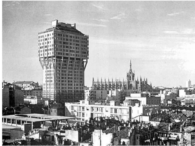
Fig.2.26: BBPR - Torre Velasca (1958), Milão
