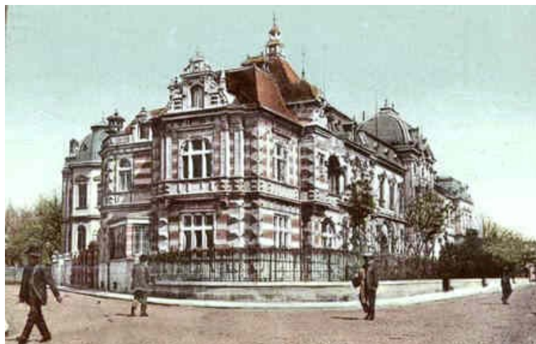
Fig.4.55: Fotografia antiga da edificação em Bucareste
