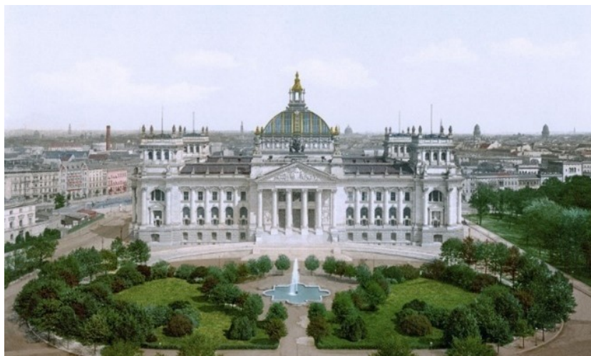
Fig.4.102: Reichstag antes da demolição da cúpula
