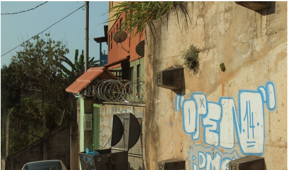
Figura 6: Fotografia de prédio do Vila Viva Aglomerado da Serra
