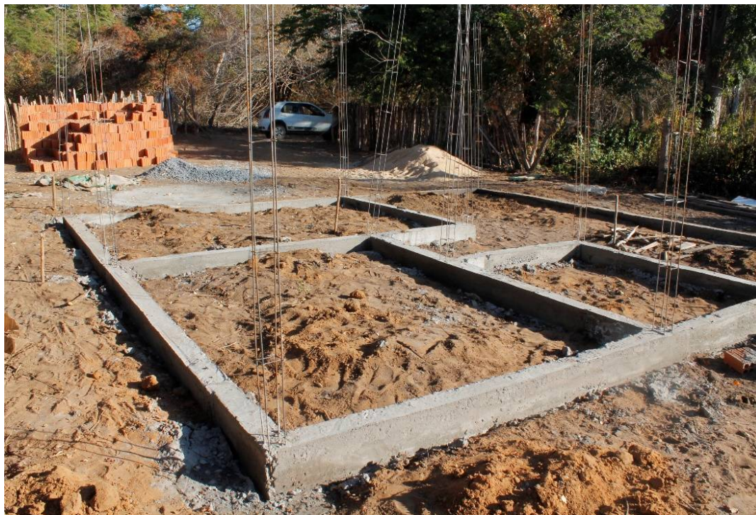
Figura 41 – PNHR: fundações de uma casa na vila São Francisco de Assis
