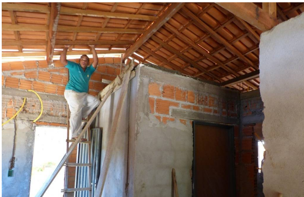
Figura 44 – PNHR: madeiramento do telhado
