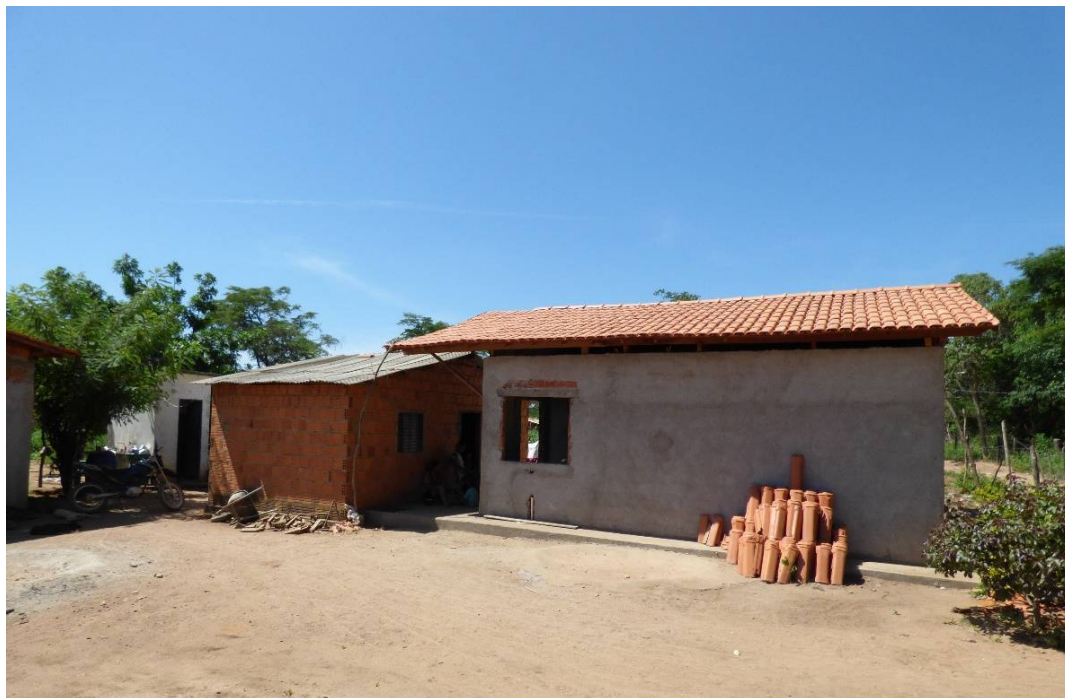
Figura 45 – PNHR: casa nova, ao lado da casa autoconstruída e do banheiro da Funasa ao fundo
