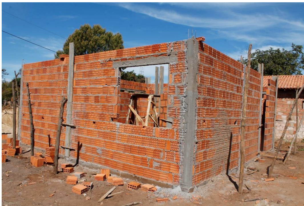
Figura 43 – PNHR: alvenaria concluída, com estrutura embutida
