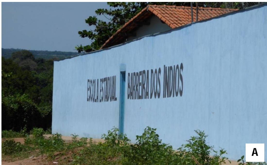
Figura 26 – Barreira dos Índios: entrada (A) e muro da Escola Estadual (B)
