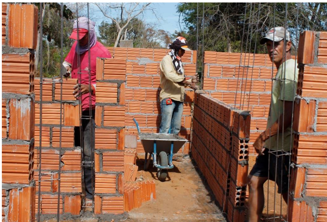
Figura 42 – PNHR: pedreiros e servente levantando a alvenaria
