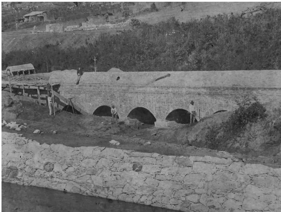
Figura 61 - Trabalhos de construção do emissário no Parque Municipal, acompanhando o Canal Arrudas (1896). Fonte: http://www.comissaoconstrutora.pbh.gov.br/
