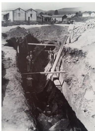
Figura 56 - Coletores principais de forma oval, em construção durante a década de 1930, similares aos construídos pela CCNC. Fonte: Acervo Museu Histórico Abílio Barreto (MHAB).
