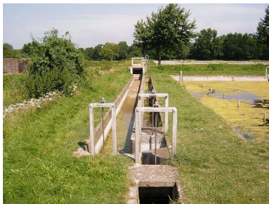
Figura 38 - Sistema de distribuição em Rieselfeld Karolinhöhe .
