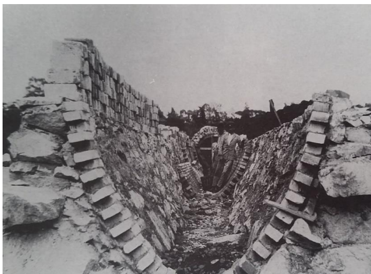
Figura 56 - Coletores principais de forma oval, em construção durante a década de 1930, similares aos construídos pela CCNC. Fonte: Acervo Museu Histórico Abílio Barreto (MHAB).
