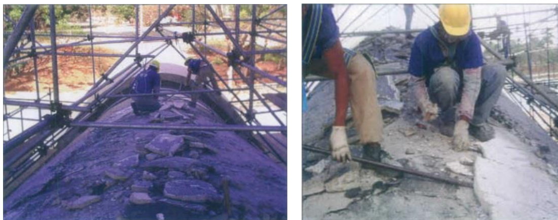
Figura 63 - Remoção das camadas no topo da abóboda principal. Figura 64 - Remoção manual dos revestimentos da abóboda principal. Fonte: AGUIAR; MORAES, 2005, p. 23.
