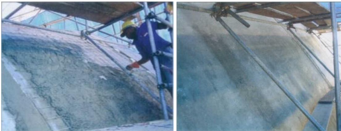
Figura 82 - Aplicação da camada de microconcreto. Figura 83 - Vista da lateral da casca após acabamento. Fonte: AGUIAR; MORAES, 2005, p. 50 - 51.
