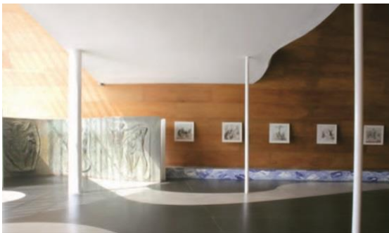
Figura 15 - Coro apoiado em colunas de ferro. Figura 16 – Abóboda principal apoiada no coro. Fonte: UNESCO, 2016.
