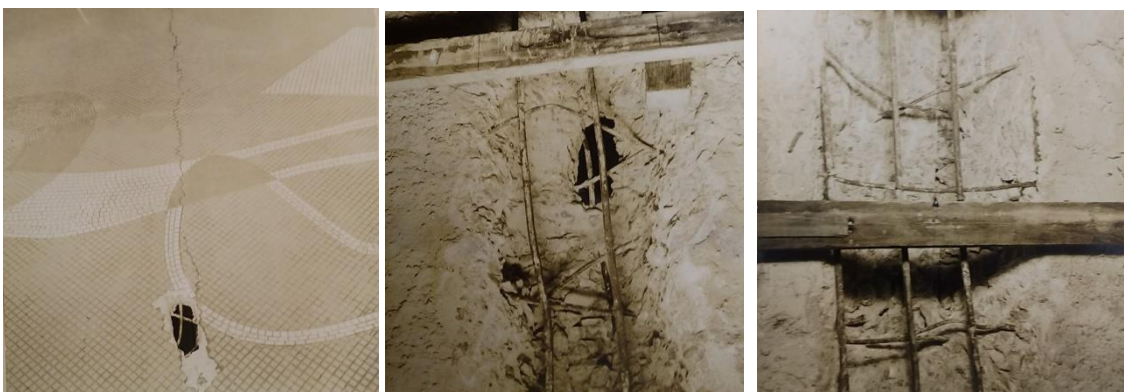
Figura 24 - Foto da prospecção da fenda externa na capela mor. Figura 25 - Foto da prospecção interna, indicando ferragens seccionadas. Figura 26 - Foto da prospecção interna legendada “junta de contração” . Fonte: IPHAN, 1955, p. 97-98.
