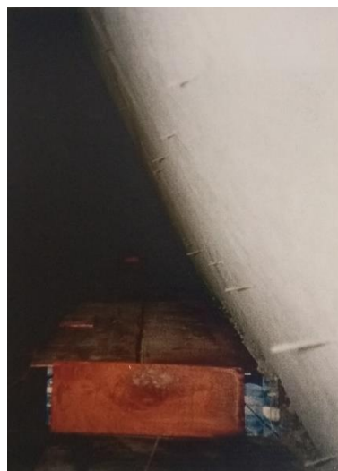
Figura 39 - Vista interna da abóboda após remoção do forro. Figura 40 - Pinos de fixação das placas de isolamento térmico. Fonte: IPHAN/MG.
