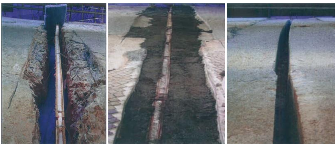
Figura 75 – Detalhe do sistema construtivo instalado no alinhamento da nova junta de dilatação. Figura 76 – Detalhe da concretagem na região dos mosaicos. Figura 77 – Aspecto final da concretagem da junta
