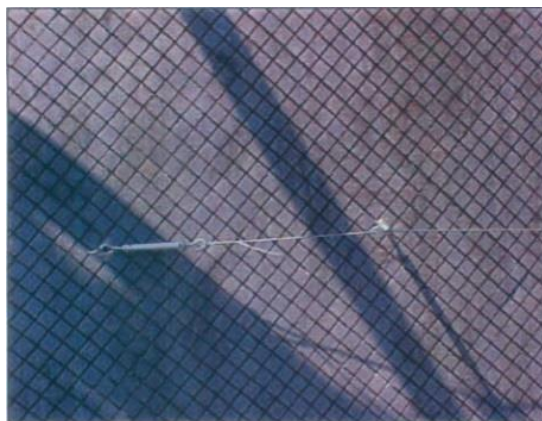
Figura 60 – Instalação de fios metálicos para referência topográfica. Fonte: AGUIAR; MORAES, 2005, p. 20.
