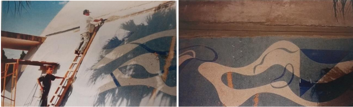
Figuras 41 e 42 - Execução e colocação de micro calha embutida para coleta e escoamento da água pluvial infiltrada entre as pastilhas. Fonte: IPHAN/MG.
