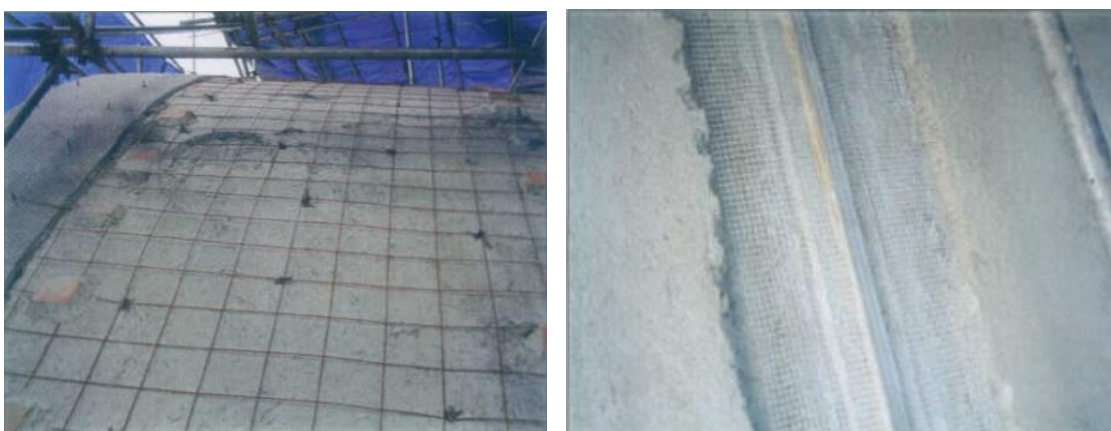
Figura 80 - Colocação da tela para garantir a aderência do micro concreto sobre a casca original. Figura 81 - Tela de fibra de vibro aplicada sobre o perfil de alumínio da junta de dilatação para evitar a corrosão galvânica. Fonte: AGUIAR; MORAES, 2005, p. 45 – 50.
