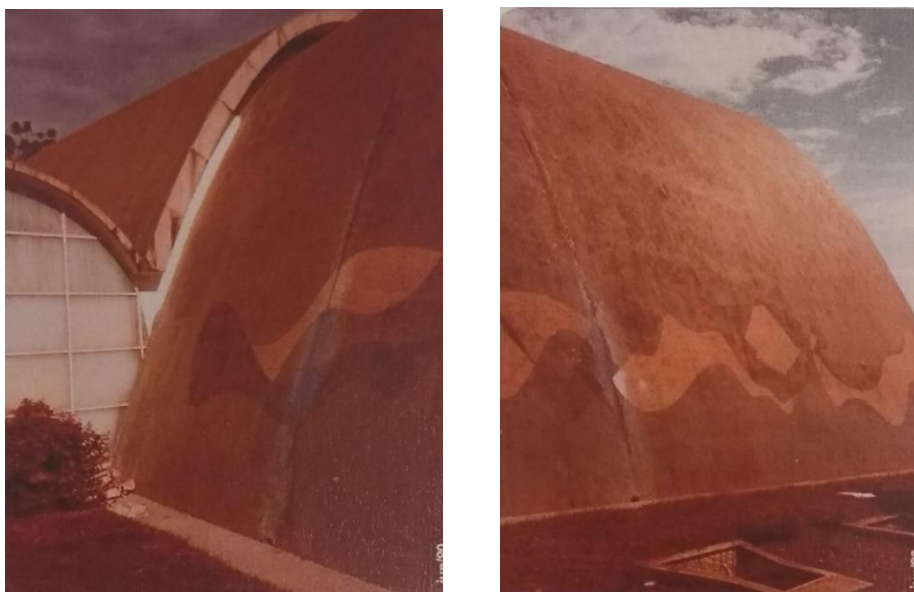
Figura 31 e 32: Situação da cobertura em junho de 1980 após reparo na calha e recomposição das pastilhas com cimento colorido. Fonte: Centro de documentação e informação do IPHAN/MG.
