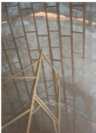
Figura 39 - Vista interna da abóboda após remoção do forro. Figura 40 - Pinos de fixação das placas de isolamento térmico. Fonte: IPHAN/MG.
