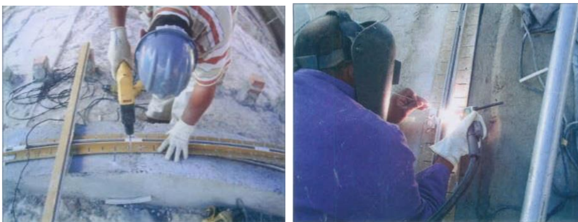
Figura 78 – Fixação dos perfis de alumínio na junta de dilatação. Figura 79 – Solda de alumínio na emenda dos perfis. Fonte: AGUIAR; MORAES, 2005, p. 43 – 44.
