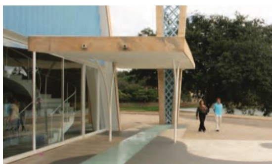
Figura 7 - Entrada da Igreja envidraçada até a altura da marquise e colunas de ferro. Figura 8 - Brise-soleils até acima da marquise. Fonte: UNESCO, 2016.
