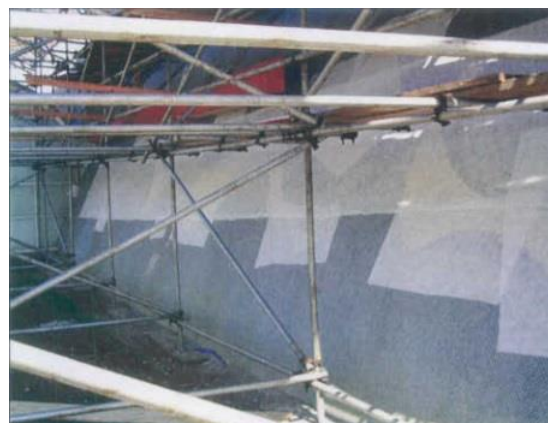
Figura 61 – Execução do mapeamento do mosaico. Figura 62 – Faceamento do mosaico com TNT. Fonte: AGUIAR; MORAES, 2005, p. 21-22.
