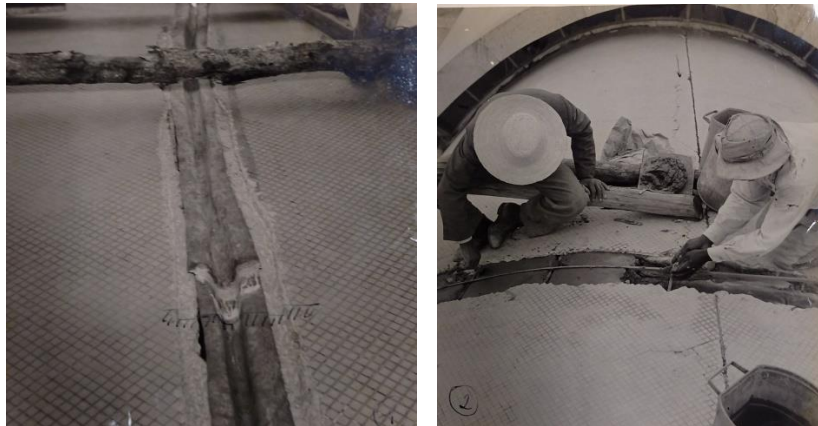
Figura 28 - Calha externa, sem estar apoiada no concreto. Figura 29: - Colocação do cimento nas calhas externas. Fonte: Arquivo Central do IPHAN/RJ.
