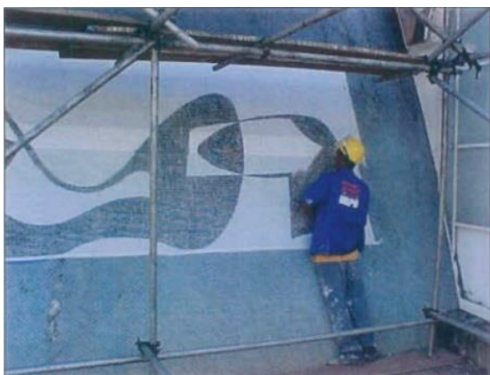
Figura 61 – Execução do mapeamento do mosaico. Figura 62 – Faceamento do mosaico com TNT. Fonte: AGUIAR; MORAES, 2005, p. 21-22.
