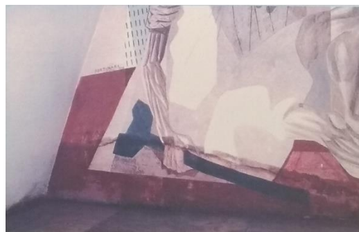
Figura 33 - Cobertura da Igreja apresentando manchas e trincas no final da década de 80. Figura 34 - Presença de umidade no mural interno no final da década de 80. Fonte: Centro de documentação e informação do IPHAN/MG.
