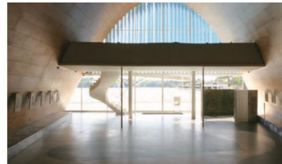
Figura 15 - Coro apoiado em colunas de ferro. Figura 16 – Abóboda principal apoiada no coro. Fonte: UNESCO, 2016.
