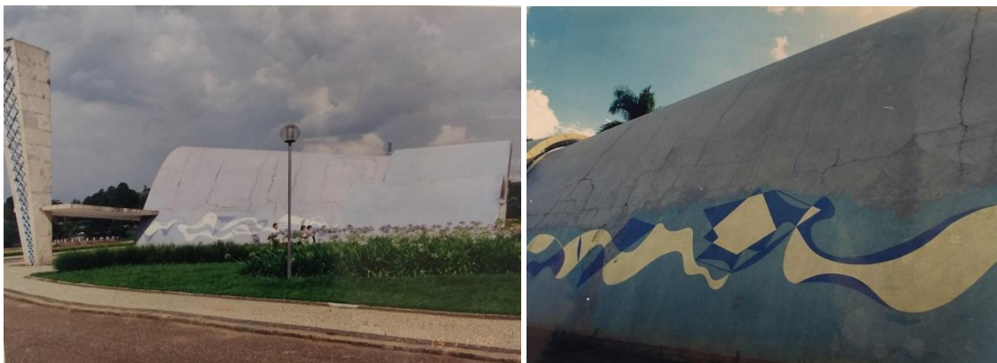
Figura 44 e 45 - Situação da Igreja em 1998, indicando problemas de fissuramento. Fonte: IPHAN/MG.
