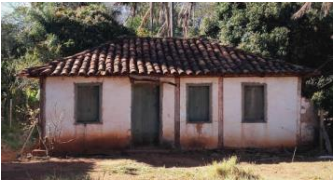
Figura 23 – Casa em adobe construída no século XIX.
