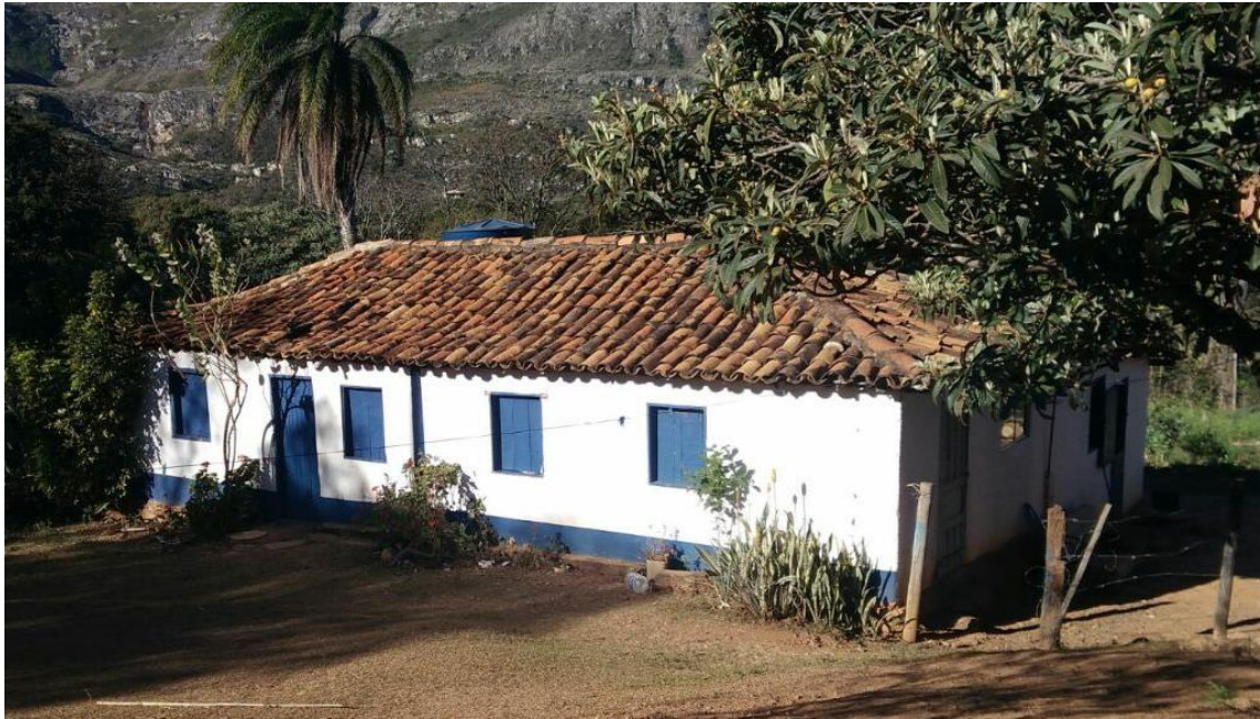
Figura 18 – Casa em adobe construída no século XIX.
