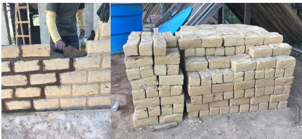
Figura 31 – Assentamento dos tijolos de adobe e cimento com argamassa e tijolos de adobe com cimento prontos para uso, Lapinha da Serra.
