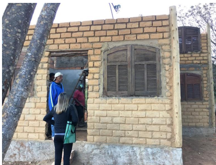
Figura 32 – Casa construída com tijolos de adobe e cimento, Lapinha da Serra.
