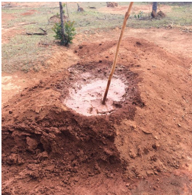
Figura 12 – Monte de terra utilizado para amassamento da terra com os pés, em Lapinha da Serra – MG.
