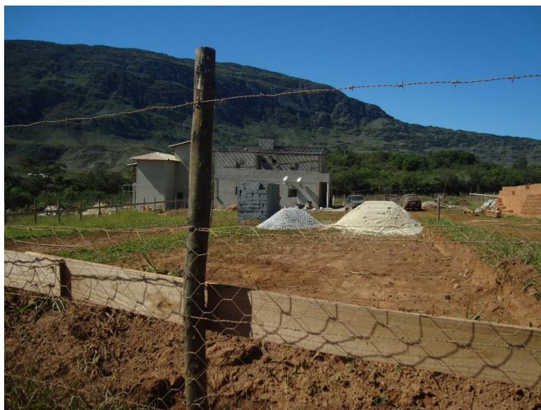
Figura 29 – Casa em construção em alvenaria estrutural. Lapinha da Serra.
