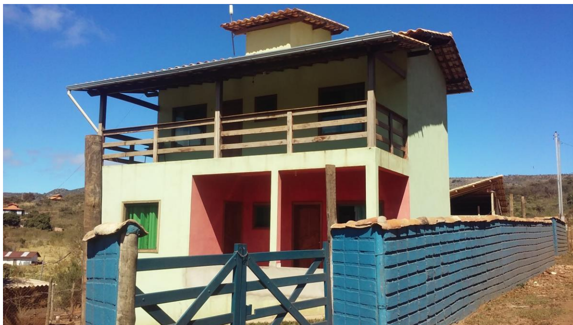
Figura 19 – Casa em alvenaria com o muro frontal imitando adobe.
