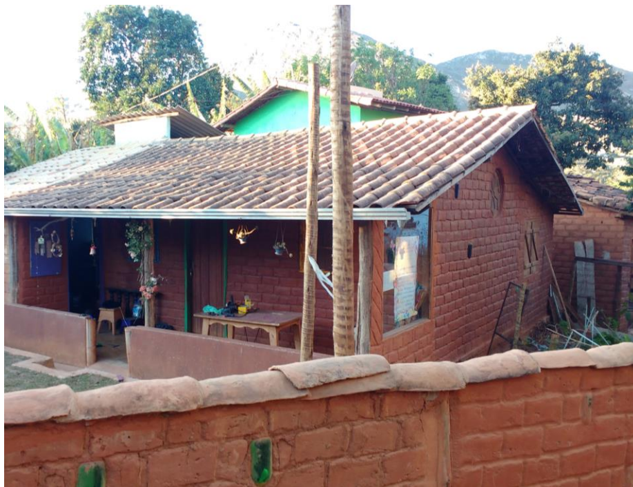
Figura 16 – Casa recente construída em adobe aparente.
