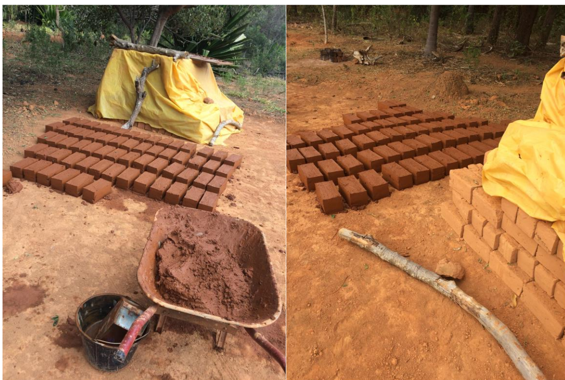
Figura 15 – Momento de secagem do adobe, com adobe seco e empilhado pronto para uso. Lapinha da Serra – MG.
