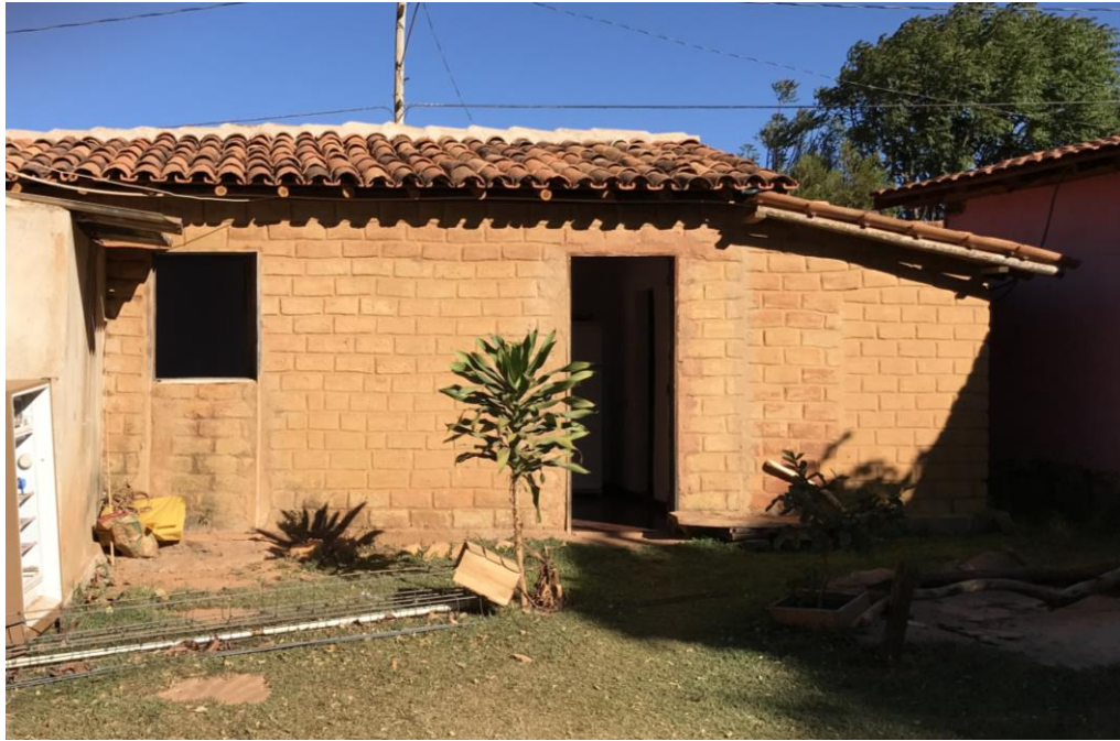
Figura 17 – Casa construída em adobe aparente.
