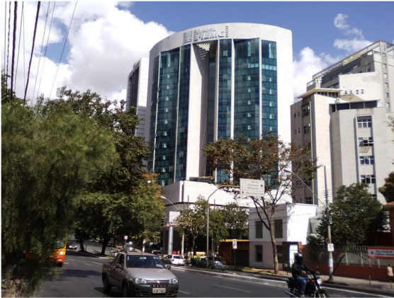
Figura 31 – Fachada frontal do edifício.
