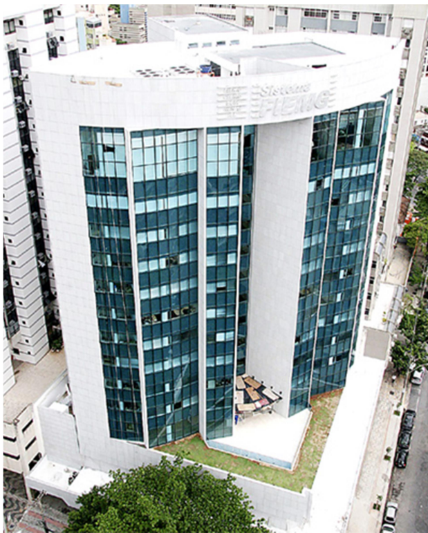
Figura 30 – Foto Edifício Robson Braga de Andrade, sede da FIEMG.
