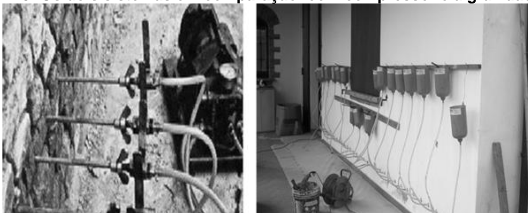
Figura 113- Os dois sistemas em comparação: com compressor e a gravidade.
