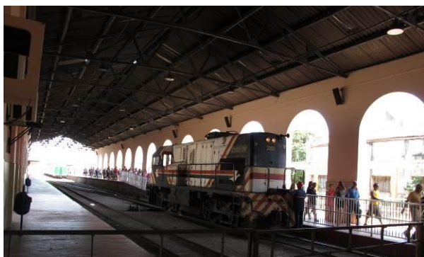
Imagem 02: gare, vista interna.
