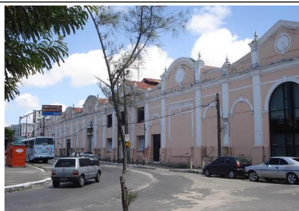
Imagem 15: galpões, vista a partir da rua 24 de maio.
