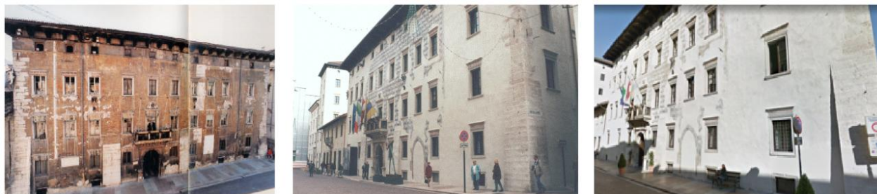
Figura 60 – O Palazzo Thun antes da intervenção (1998) e após a intervenção (2001) e a eficácia da intervenção 15 anos depois (2016).
