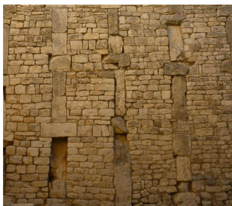
Figura 18 - Exemplo de alvenaria em Opus africanum – Cartagena (Tunísia)
