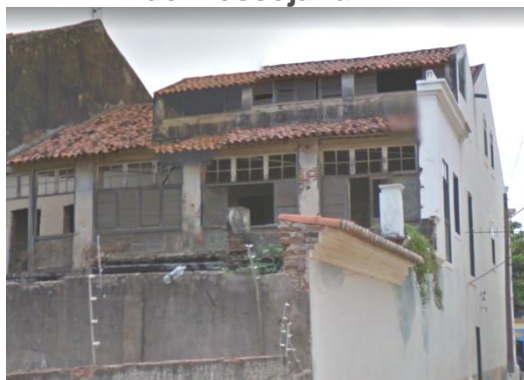
Figura 156 – Fachada posterior da edificação vista a partir da Travessa Barão de Messejana
