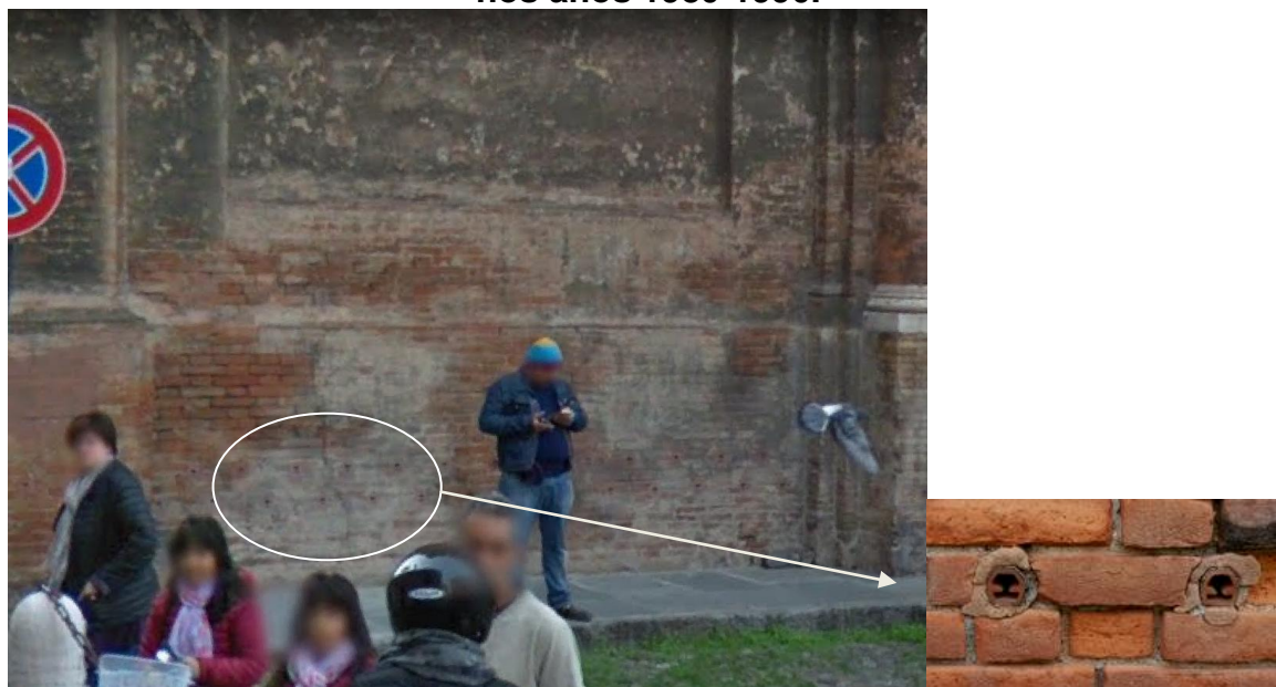
Figura 109 - Imagem da fachada da Igreja Sant'Agostino em Modena, com os sifões Knapem (no particular). Evidente a ineficácia da intervenção ocorrida nos anos 1980-1990.
