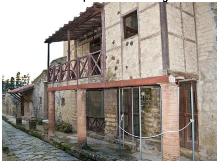
Figura 23 - Casa em Opus Craticium , em Herculano (Nápoles). Reconstrução do edifício original.
