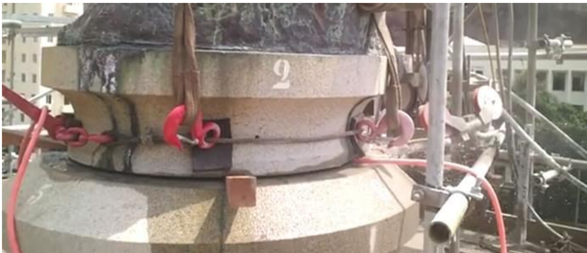
Figura 119 – O corte do Monumento aos Heróis de Laguna e Dourados em granito.
