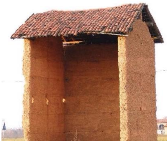
Figura 43 - Exemplo de construção “Trumera” na Província de Alessandria.
