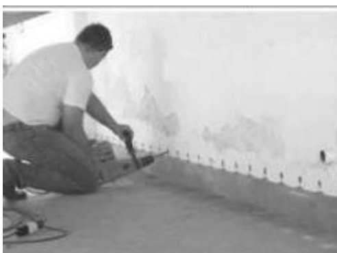
Figura 107 - Exemplo da execução dos furos na parede.
