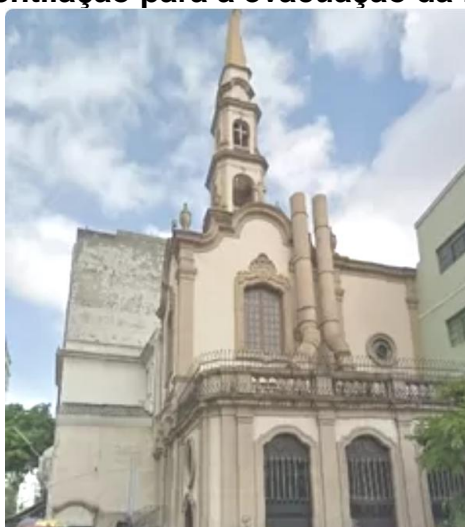
Figura 9 - A Igreja Santa Cruz das Almas dos Enforcados em São Paulo, tombada pelo patrimônio. Nota-se no lado direito os condutos do sistema de ventilação para a evacuação da fumaça das velas.
