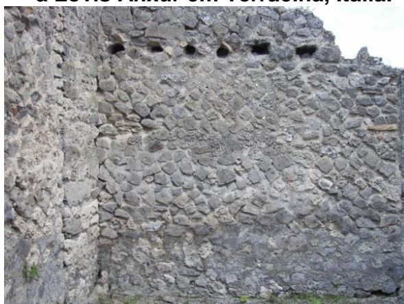
Figura 21 - Tipo de alvenaria com a técnica Opus incertum no Templo dedicado a Lovis Anxur em Terracina, Itália.
