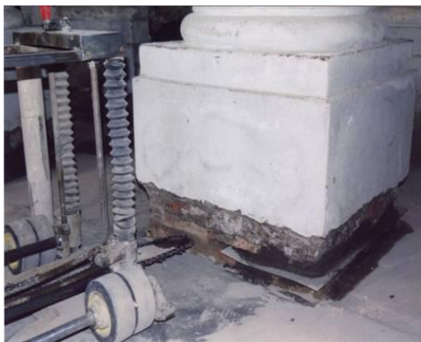
Figura 115 - Exemplo de corte de uma coluna na intervenção dos anos 1980 no Museu do Louvre.
