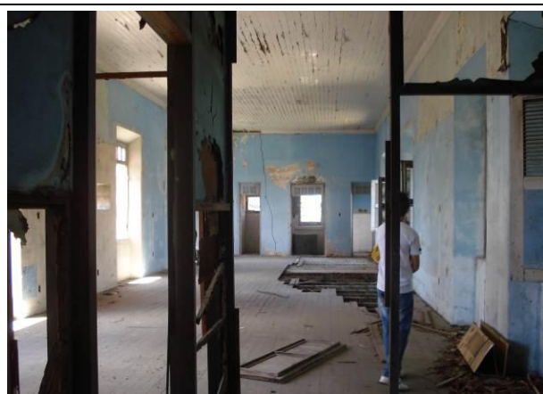
Imagem 12: Bloco K via permanente, vista interna do primeiro pavimento.
