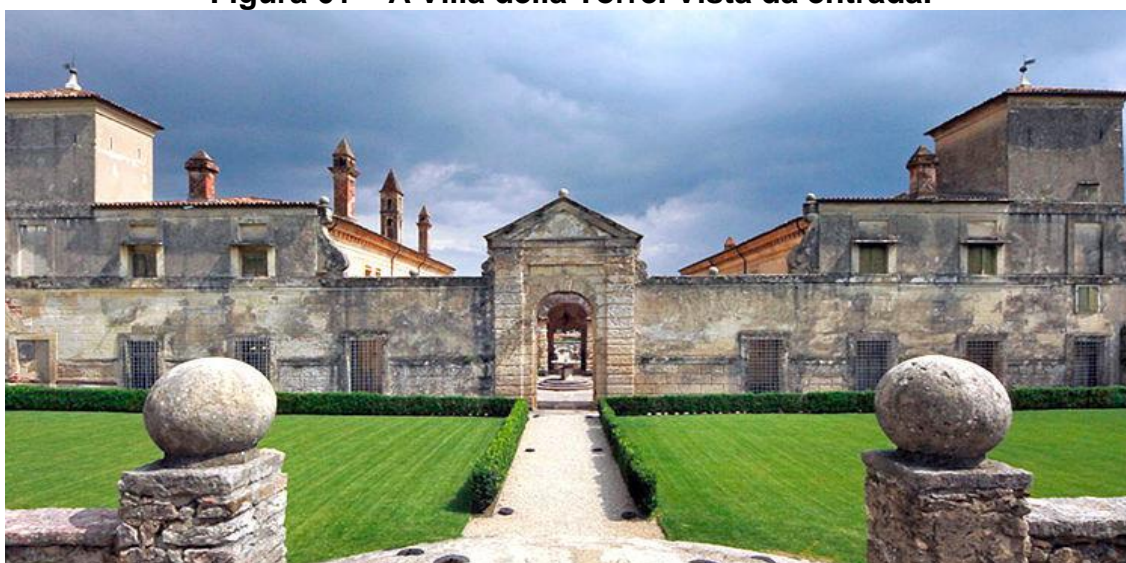
Figura 61 – A Villa della Torre. Vista da entrada.
