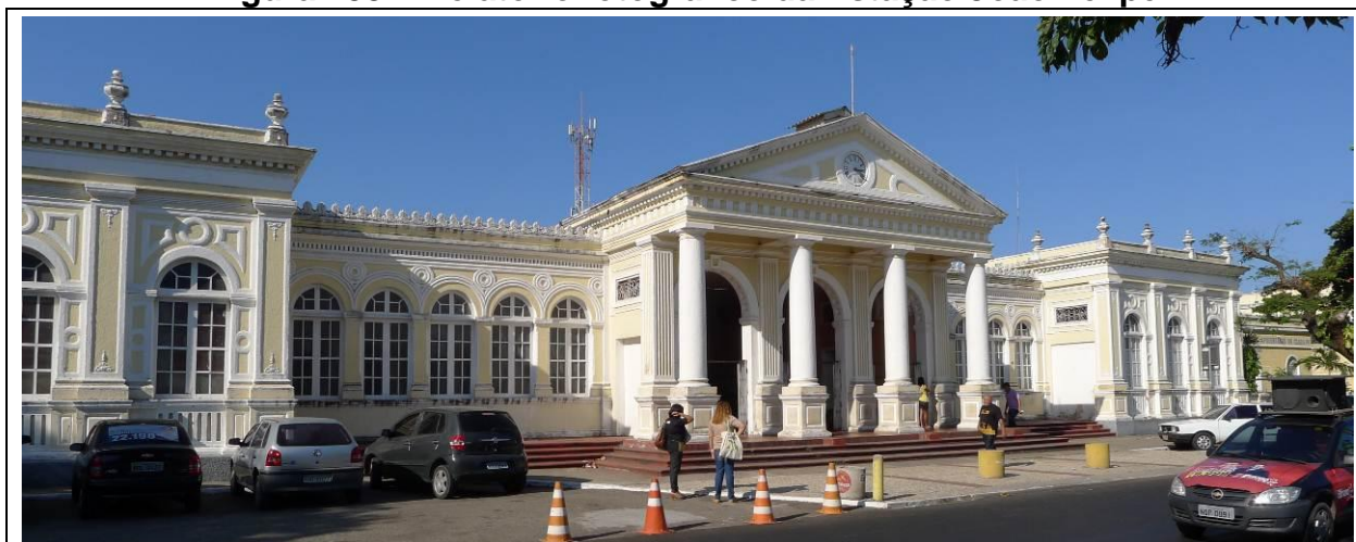
Figura 138 – Relatório fotográfico da Estação João Felipe.
