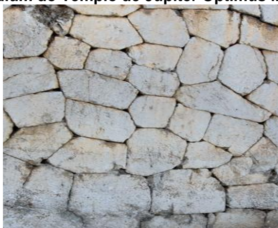
Figura 16 - Exemplo de Opus Silicium: a) Muro urbano em Fondi b) o podium do Templo de Jupiter Optimus Maximus.
