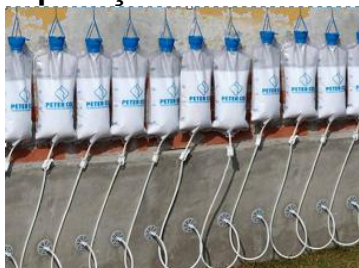
Figura 58 – Aplicação da barreira química.
