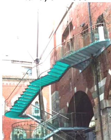
Figura 11 – Projeto do arquiteto Marco Dezzi Bardeschi, da nova escada de acesso e saída de emergência do Palácio da Ragione em Milão na Itália, em 1999.
