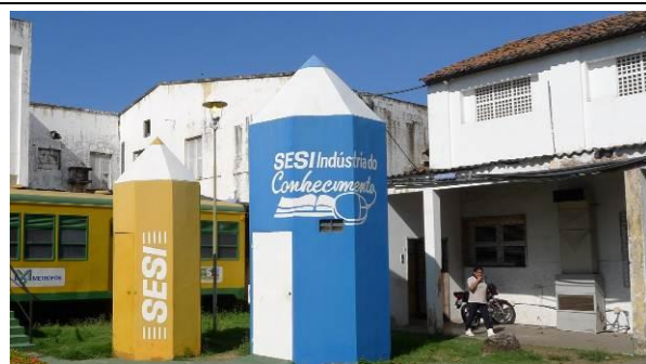
Imagem 06: bloco da eletrotécnica (ao fundo) e do serviço social (à direita), vistos a partir do pátio interno.
