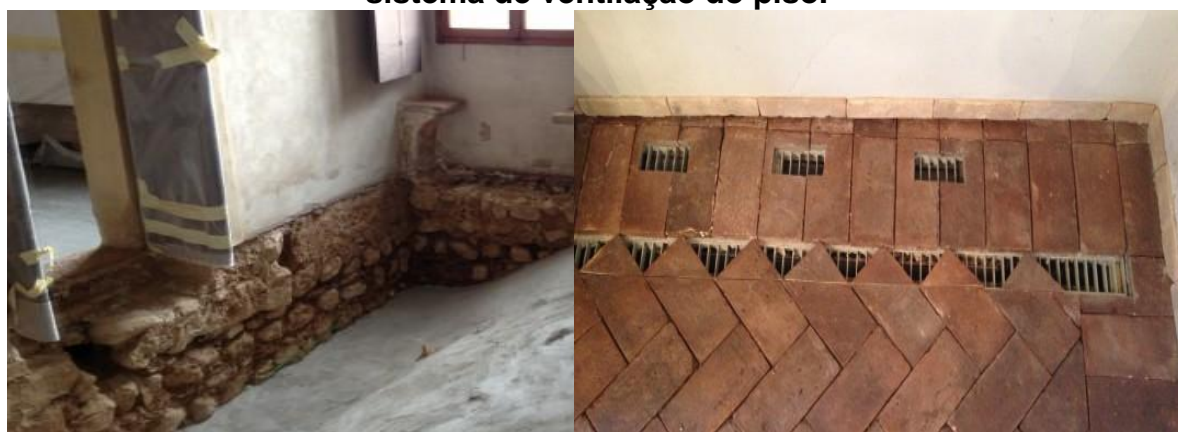
Figura 69– Imagens das intervenções: a técnica de transformação dos sais e o sistema de ventilação do piso.
