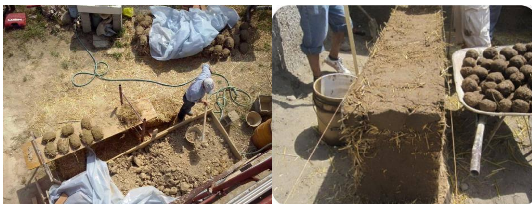
Figura 42 - A preparação dos “massoni” no Abruzzo
