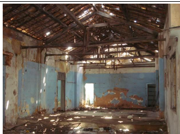
Imagem 13: depósito de material de pontes, vista interna.
