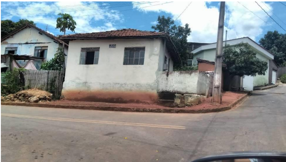
Figura 28: Macaia antiga- exemplo de residência existente no local
