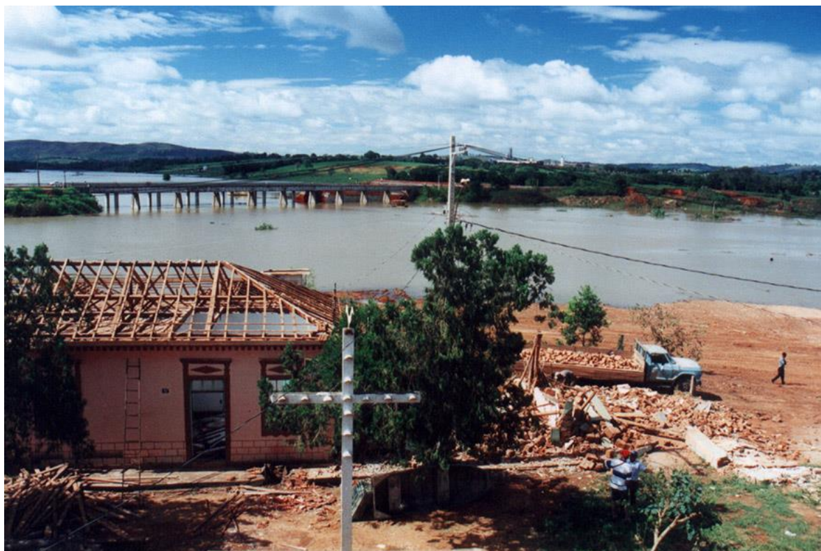
Figura 61: Habitação sendo demolida
