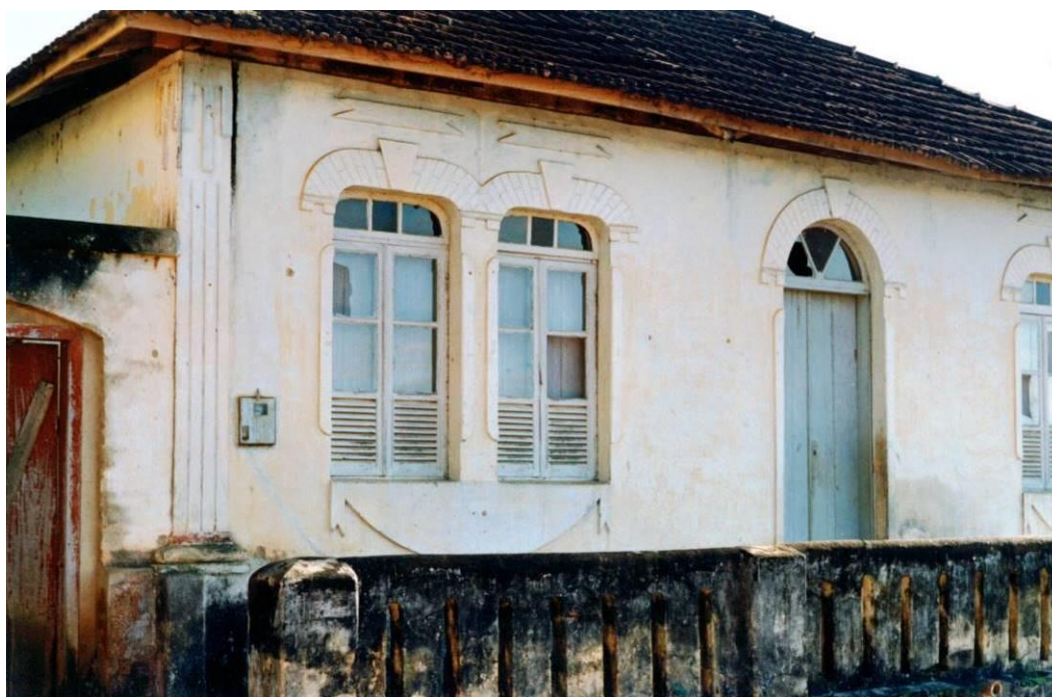
Figura 22: Detalhe da fachada da Santa Casa de Macaia
