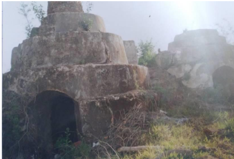
Figura 8: Forno da Usina de Cal de Macaia
