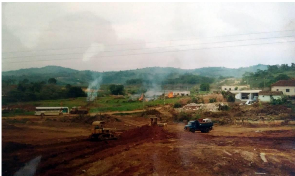
Figura 60: Processo de demolição das edificações
