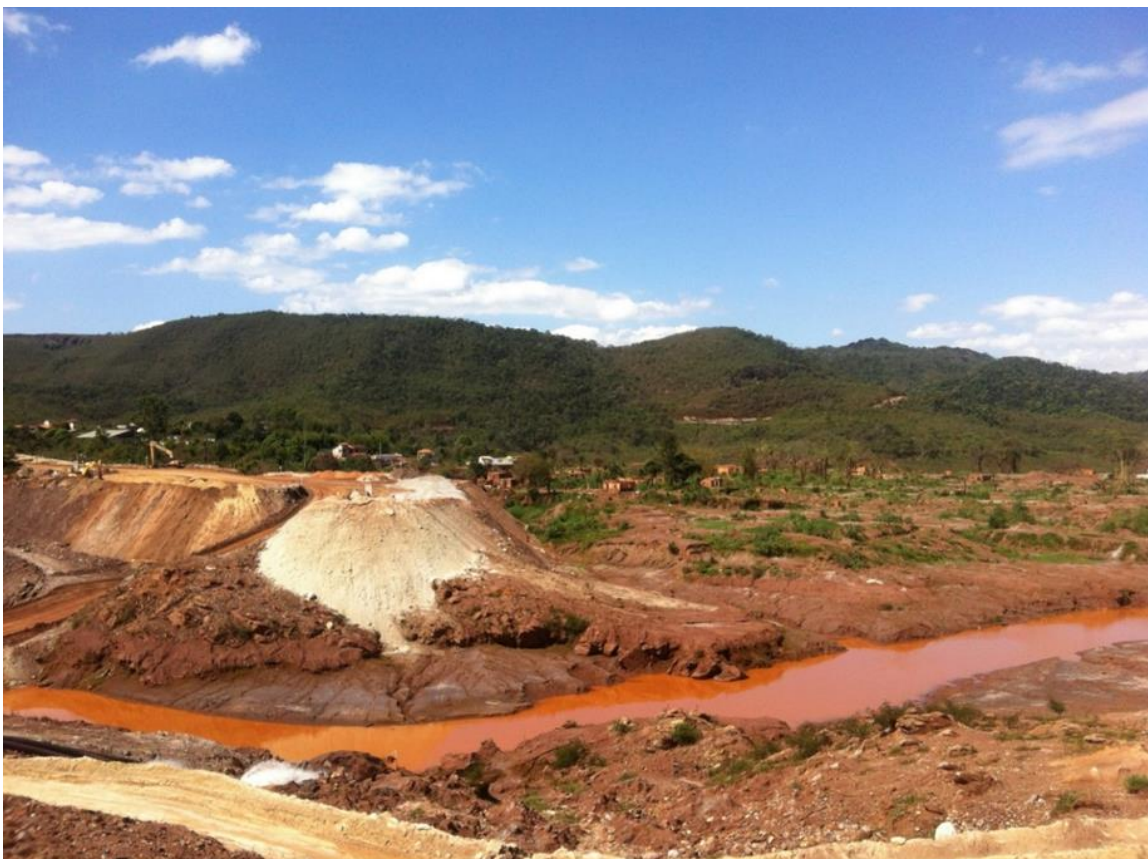
Figura 13 - Bento Rodrigues, MG, construção do dique S4.
