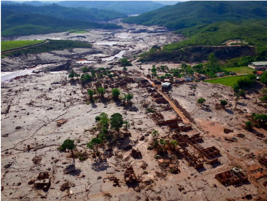
Figura 8 - Bento Rodrigues após o rompimento da barragem de Fundão.
