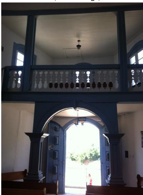
Figura 68 - Capela Nossa Senhora do Rosário, interior da nave, Barra Longa, MG.
