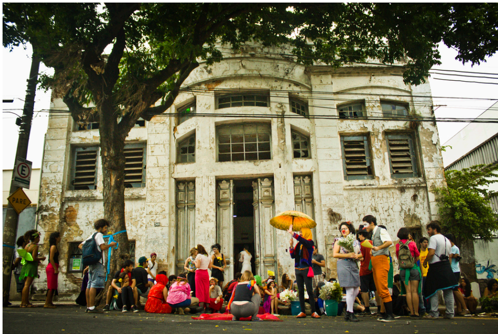
FIGURA 37 Fachada do Espaço Comum Luiz Estrela
