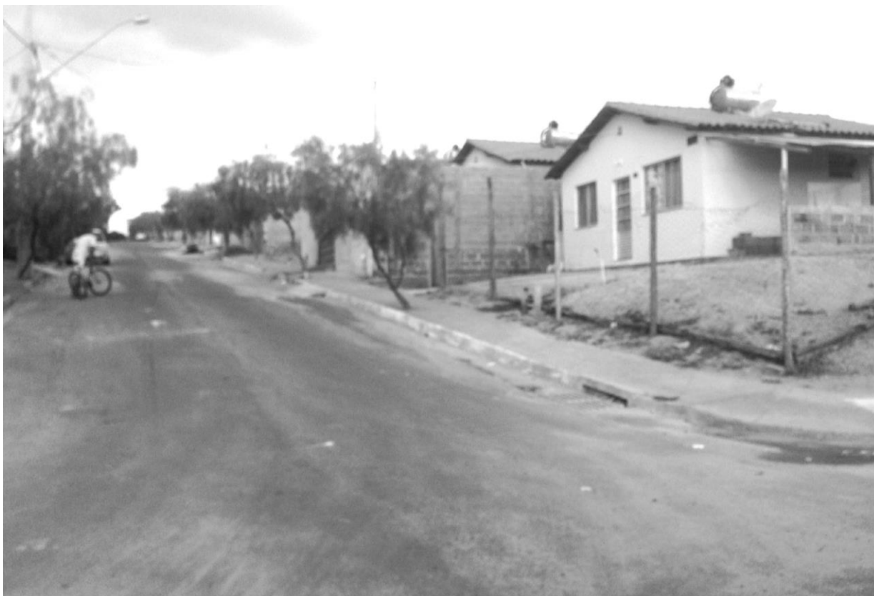
Figura 36: Vista de uma das ruas íngremes do conjunto habitacional Geraldo Veloso.
