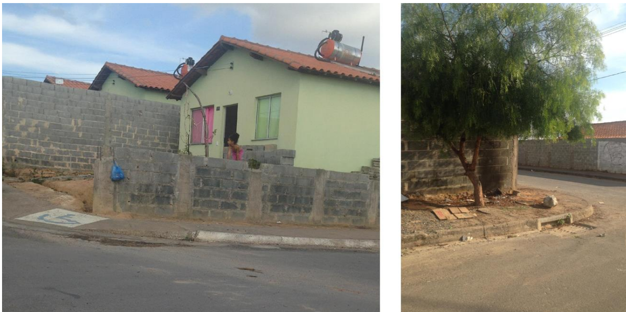
Figura 41: Situação dos rebaixos de calçadas com esquinas sem rebaixos.
