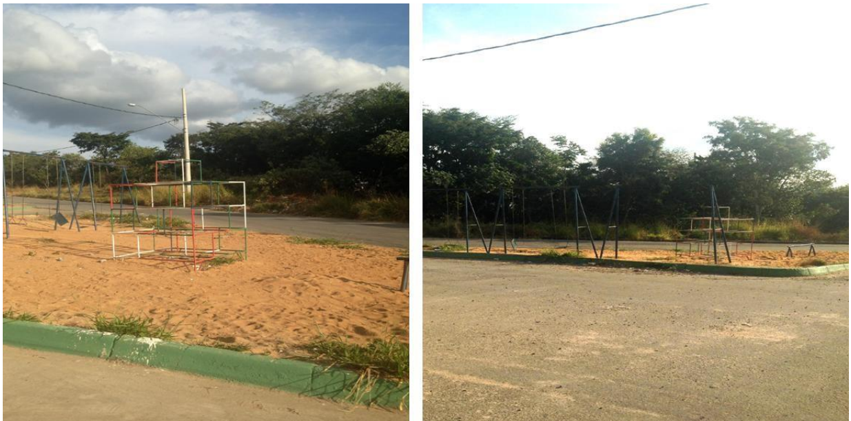
Figura 50: Parquinho construído em local destinado a área verde.
