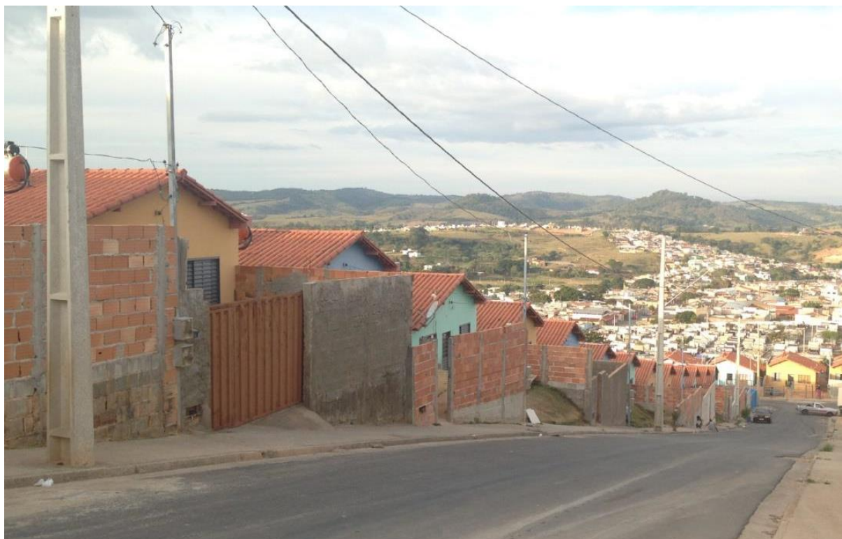
Figura 29: Situação das calçadas.
