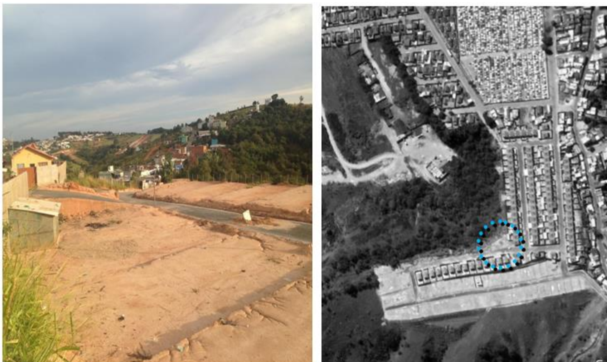
Figura 24: Condições de acesso a oeste do conjunto habitacional.
