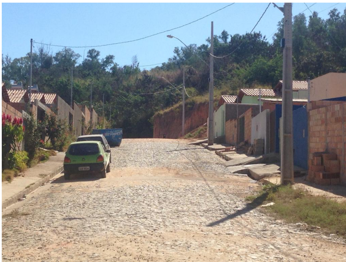
Figura 60: Rua sem saída e barranco ao fundo.
