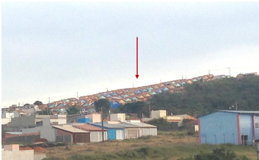
Figura 8: Vista geral do conjunto habitacional Alto dos Bandeirantes.
