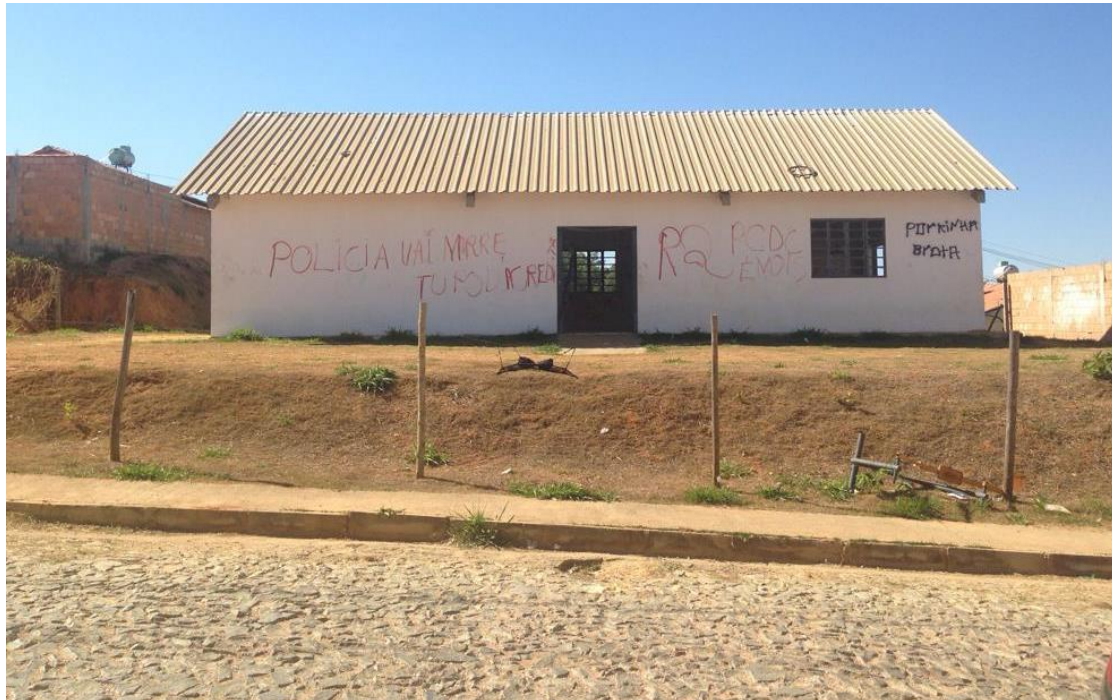
Figura 62: Edificação prevista para uso institucional no CH Dona Branca.
