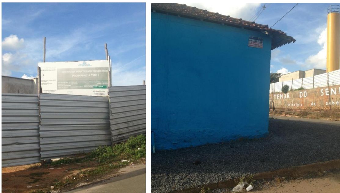
Figura 49: Unidade escolar infantil em execução
