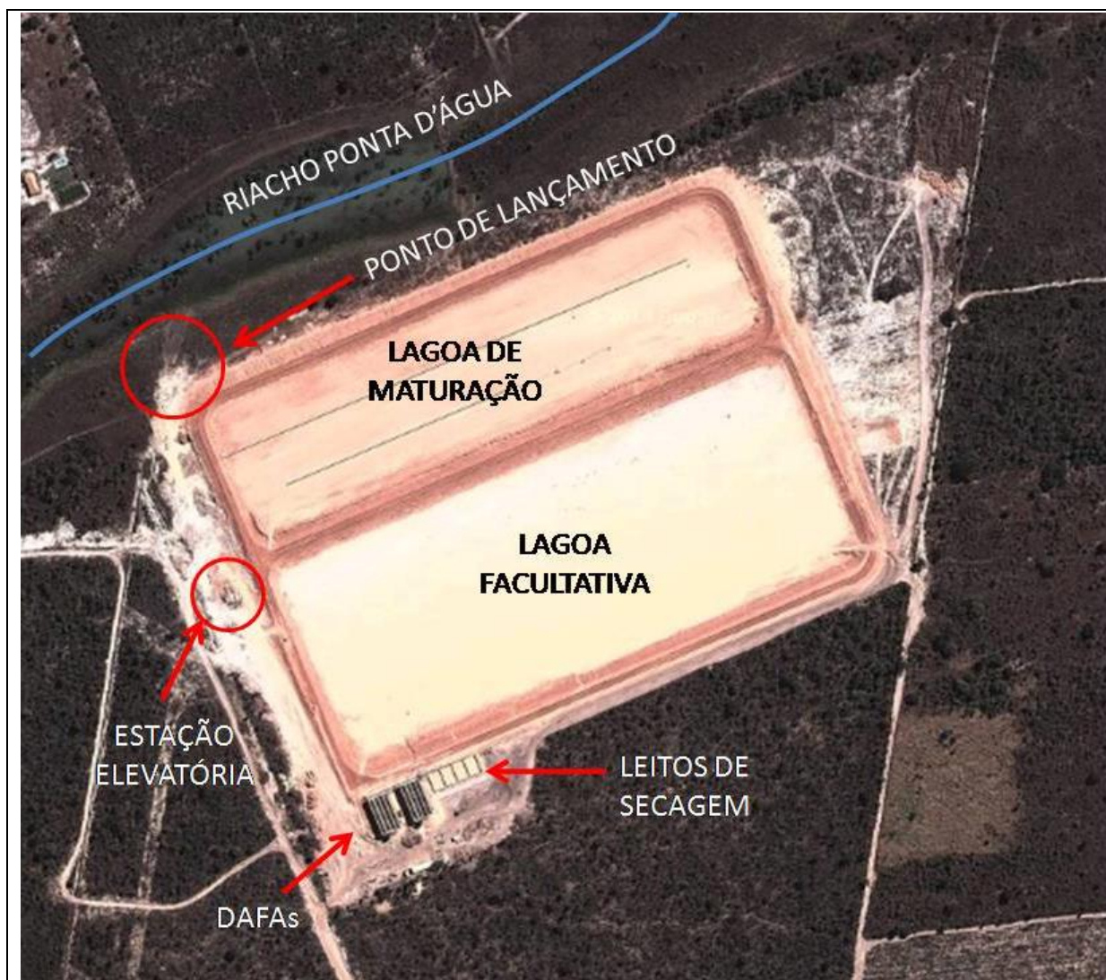
Figura 14 – Recorte de Imagem de Satélite Google Earth com Demonstração das Estruturas da Estação de Tratamento de Esgoto e Ponto de Lançamento do Município de Luís Eduardo Magalhães, BA.
