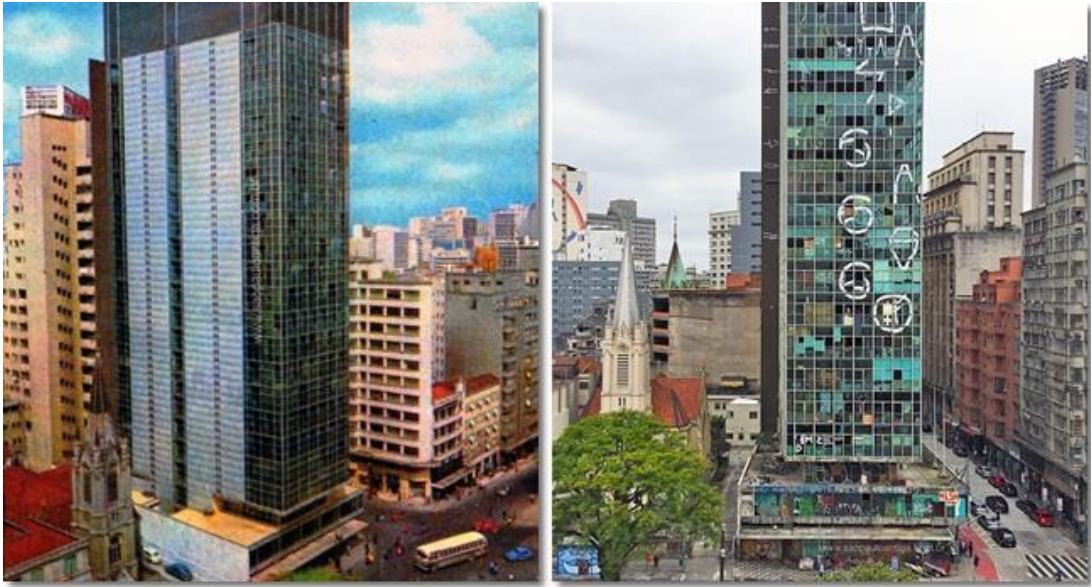
Figura 7 - Edifício Wilton Paes de Almeida em 1969 (esq.) e em 2016 (dir.)
