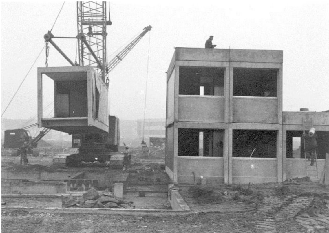
Figura 32- Processo de montagem do sistema Variel, no campus da VUB
