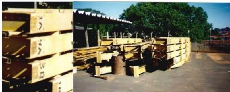
Figura 16 - Identificação das peças durante a desmontagem
