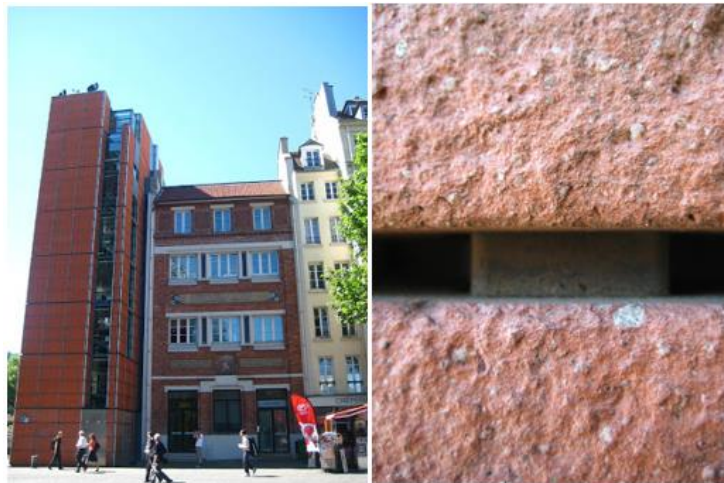
Figura 19 - Fachada do IRCAM e edifício existente (esq.) e Detalhe construtivo utilizado na construção (foto à dir.)
