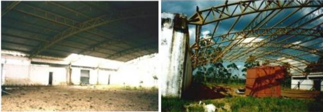
Figura 15 - Cobertura do Hangar
