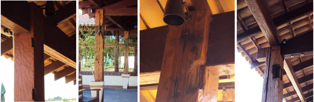
Figura 14 – Detalhes das marcas das conexões nas peças de madeira reutilizadas
