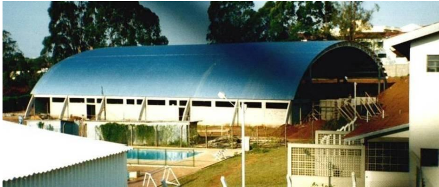
Figura 18 - Conclusão da cobertura do ginásio da USP-SC
