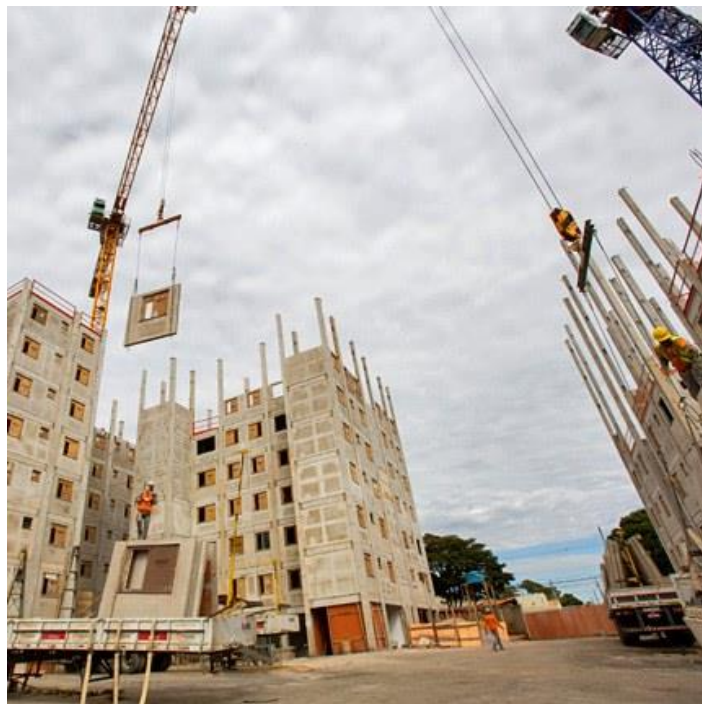
Figura 20 - Processo de montagem da Solução Habitacional Precon (SHP)
