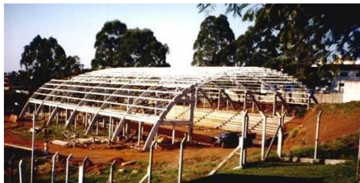
Figura 17 - Processo de montagem da cobertura do ginásio
