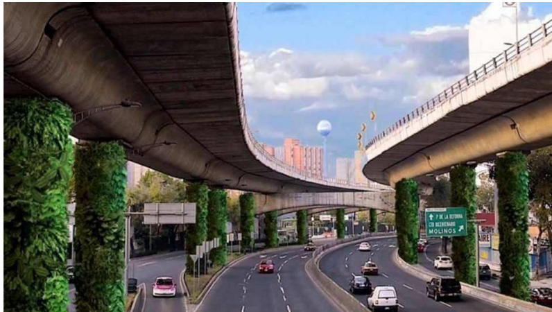
Figura 13: Jardim vertical em pilares na Cidade do México.
