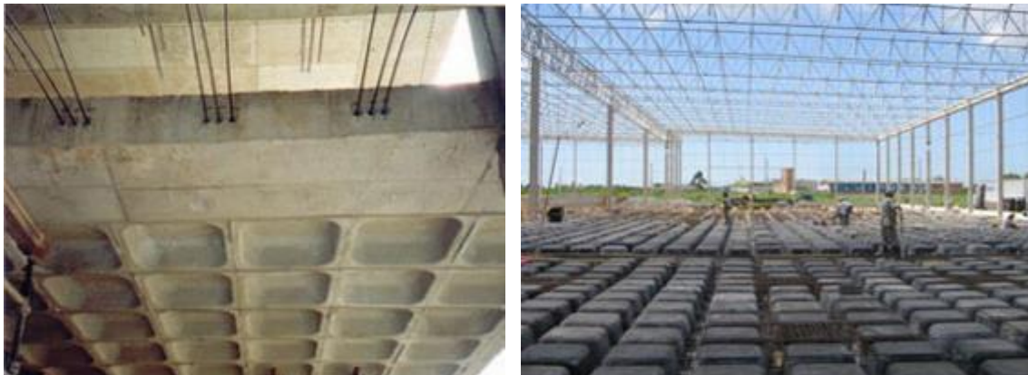
Figura 69 – Vista de lajes nervuradas ATEX.
