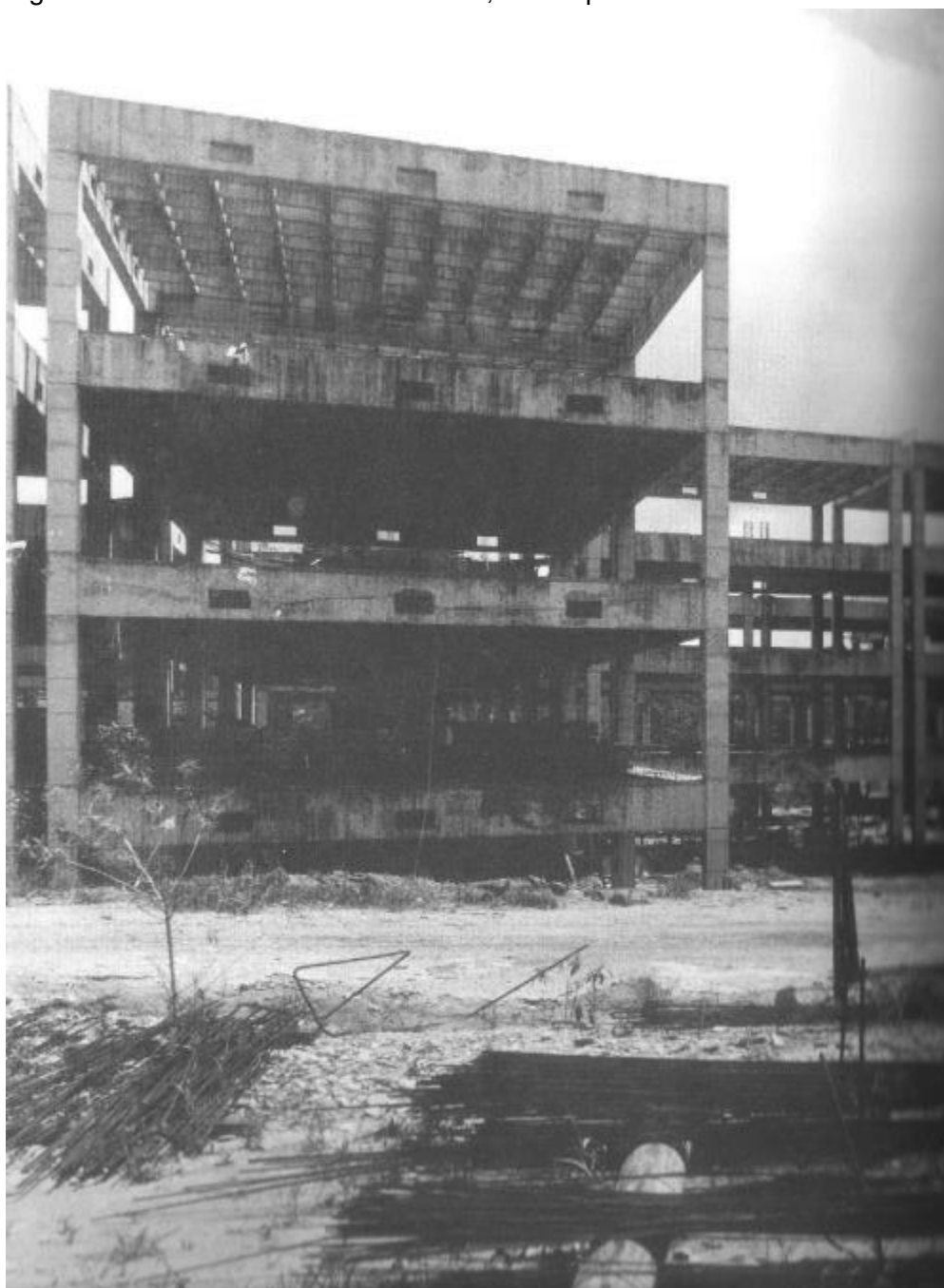
Figura 67 — Vista da estrutura modular, 90 cm por 90 cm do Sistema Básico, em 1980.
