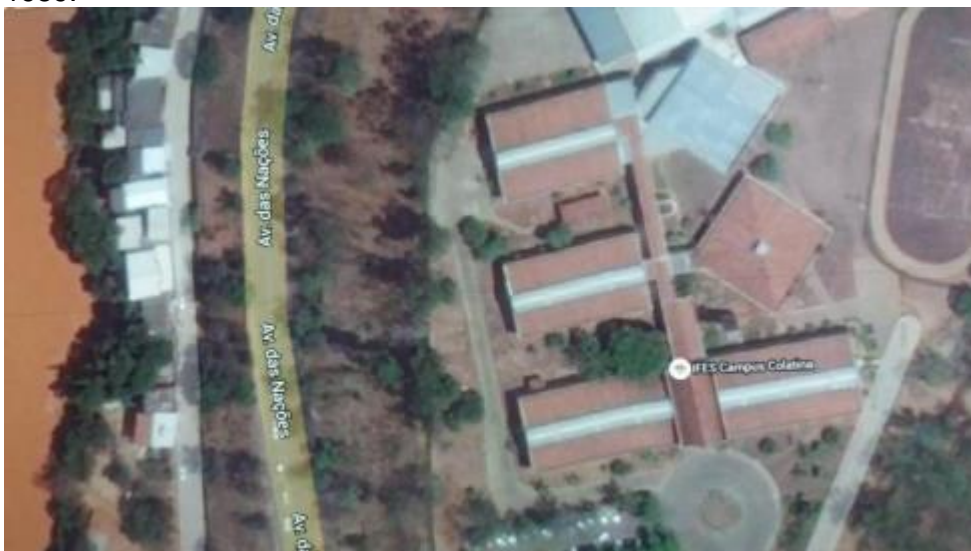
Figura 171 — Estrutura pavilhionar Instituto Federal Campus Colatina/ES, construído em 1989.
