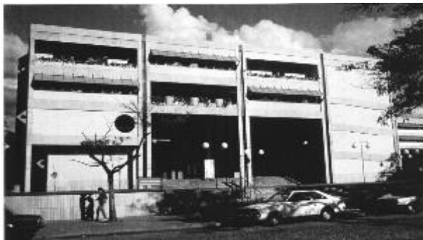
Figura 122 – Pórtico de entrada da ECI.
