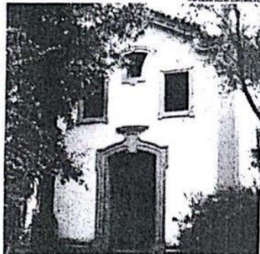
Fachada de igreja de São João Batista, provavelmente construída no século 18, que será transferida para a UFMG.
