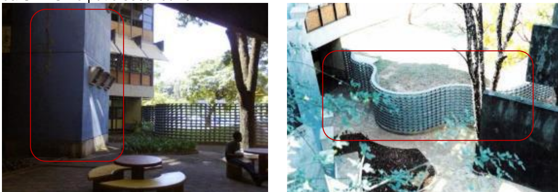
Figura 132 – EBA ampliada em 1992. Destaques: a) torre de serviços; b) muros de cobogós da UFMG no pátio secundário.
