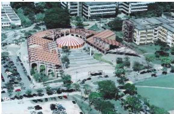
Figura 81 – Vista aérea da Praça de Serviços, Campus Pampulha, 1992.
