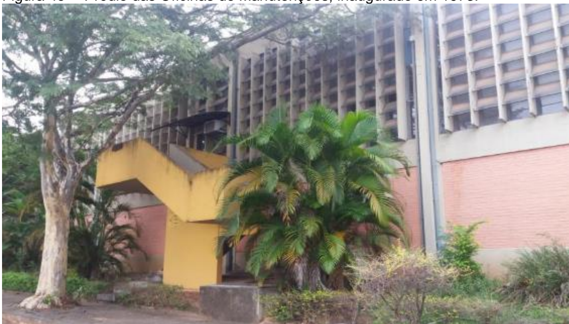
Figura 45 – Prédio das Oficinas de Manutenções, inaugurado em 1973.
