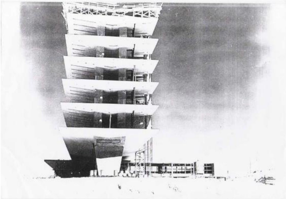
Figura 26 – Estrutura do prédio da Reitoria, em 1956.
