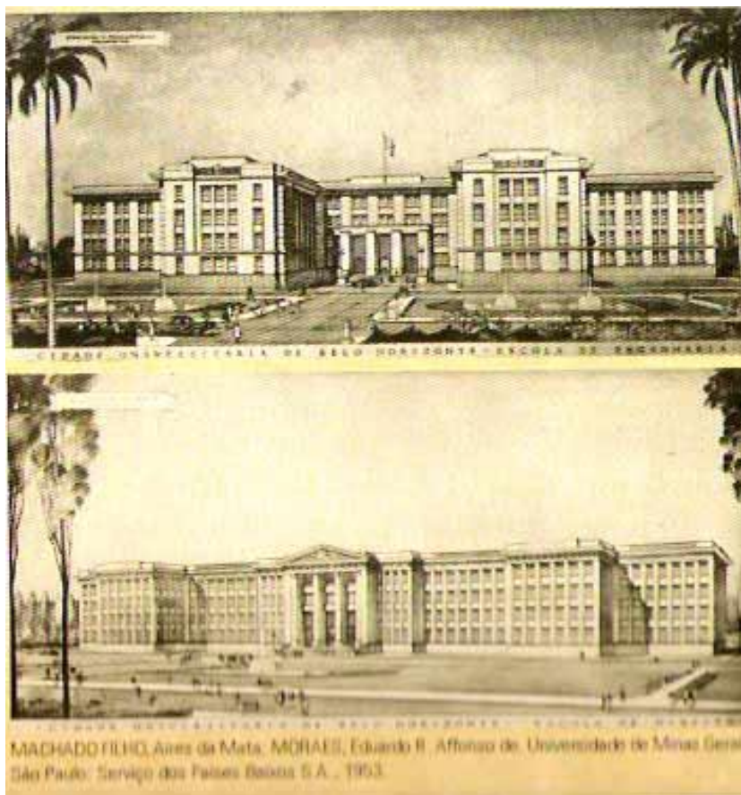
Figura 21 – Fachadas dos edifícios no Campus Pampulha, projeto de Eduardo Pederneiras, em 1947.
