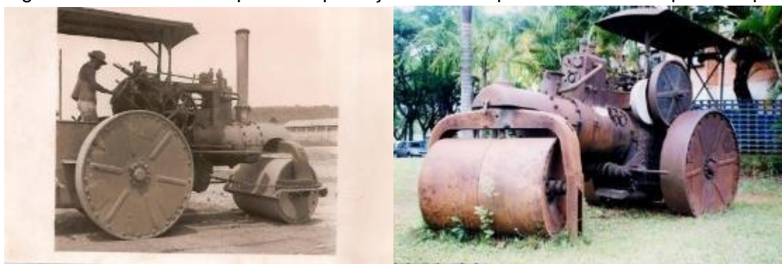
Figura 186 — Macadame para compactação ruas nos primórdios do Campus Pampulha.
