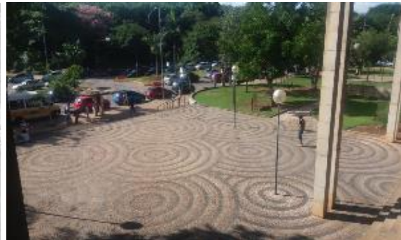
Figura 123 – Pórtico de entrada, próximo à rua e tratamento de piso na ECI.
