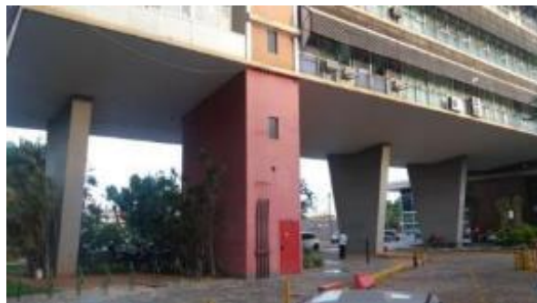
Figura 38 — Escada de incêndio da Reitoria.
