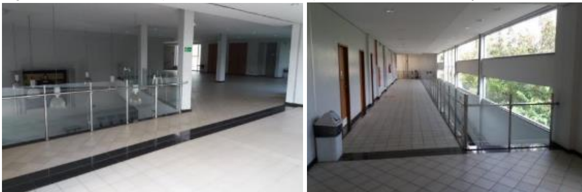
Figura 197 — Guarda-corpos do mezanino e rampa da EE em blindex e aço inox.
