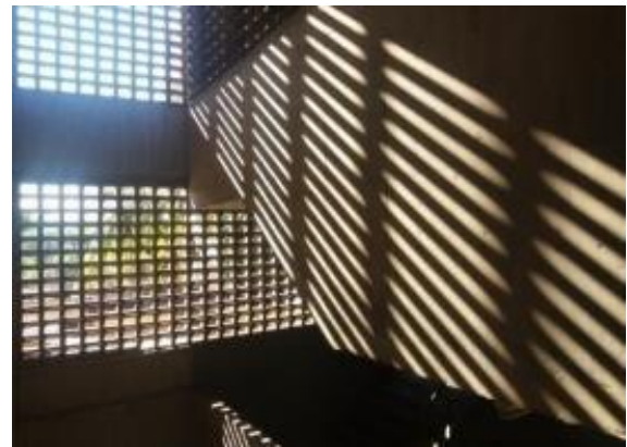
Figura 59 — Sistema Básico, interior FALE. Detalhe iluminação pelos cobogós.
