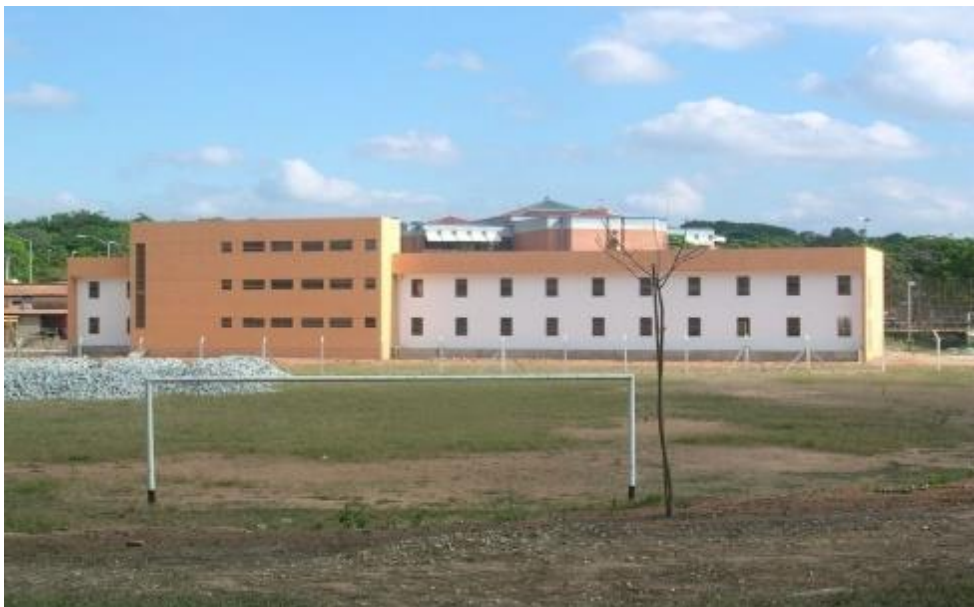
Figura 146 – Vista prédio do Departamento de Planejamento e Projetos-DPP.
