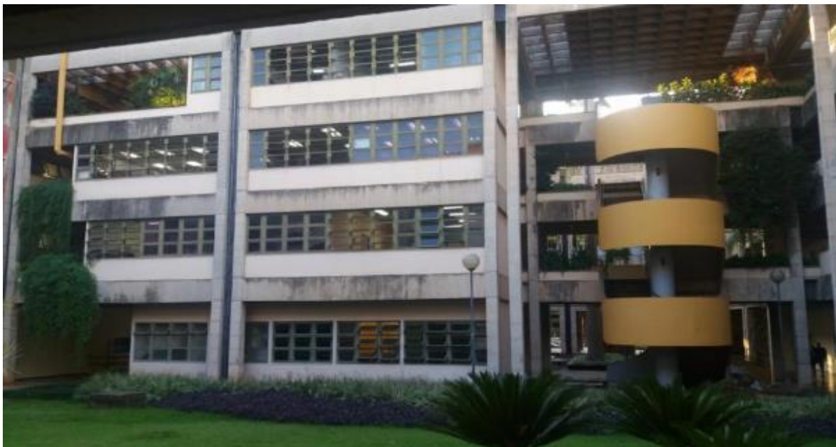
Figura 85 – Volume de escada e detalhes arquitetônicos e paisagísticos enriquecedores. Sistema Básico, ECI.
