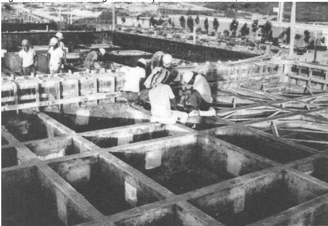
Figura 66 — Estrutura em grelha do Departamento de Física, 1974.
