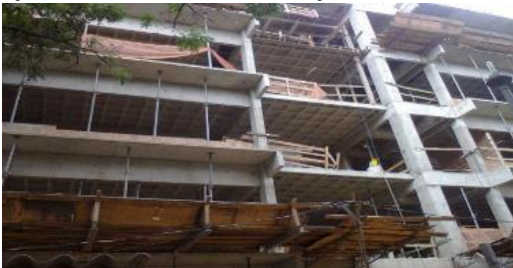
Figura 168 – Anexo atual EBA com estrutura em grelha.
