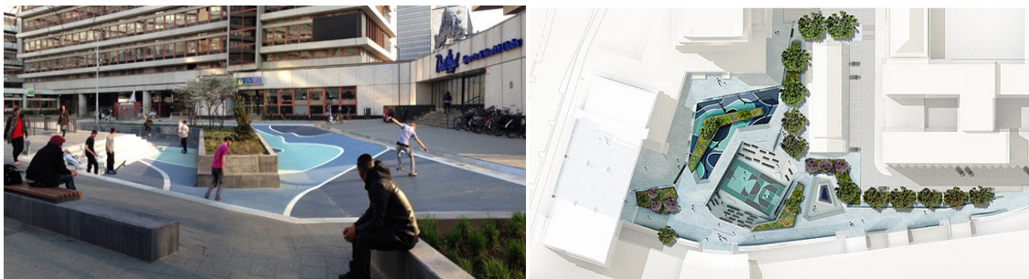
Fig. 9 Waterplein Square Bentemplein ocupada por moradores em dias ensolarados (a); Projeto geral da praça com as três bacias de captação pluvial (b) (URBANISTEN, 2013)
