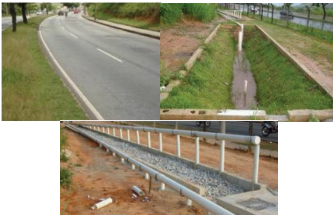
Fig. 12 Vista parcial de uma das áreas de captação descentralizada de água pluvial (a); Trincheira de retenção (b); Trincheira de infiltração (c). (SILVA, et al , 2010)
