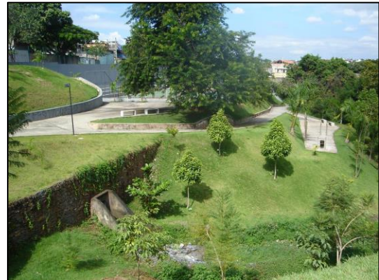
Figura 24 - Parque Ecológico 1º de Maio (obra concluída)
