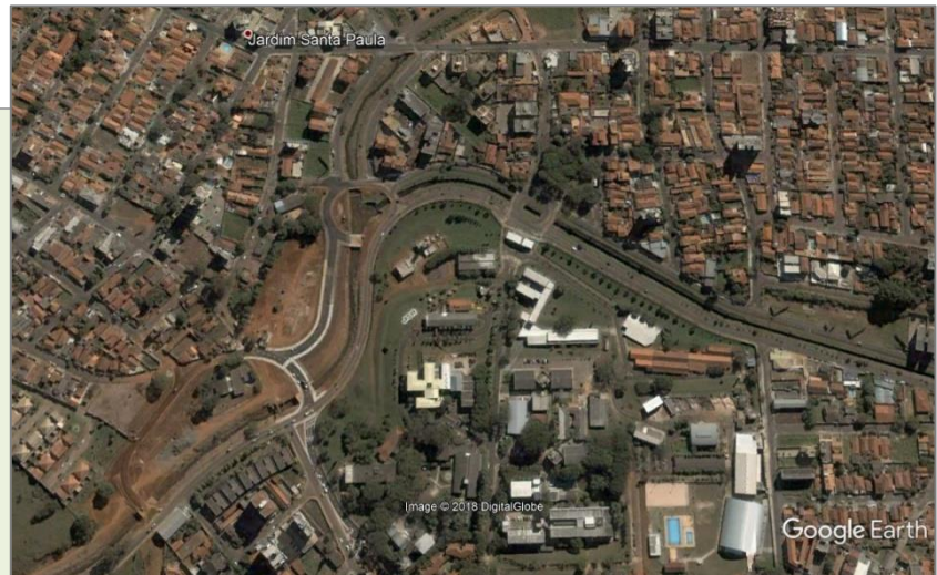
Figura 8 - Intervenções viárias na Av. Dr. Francisco Pereira Lopes
