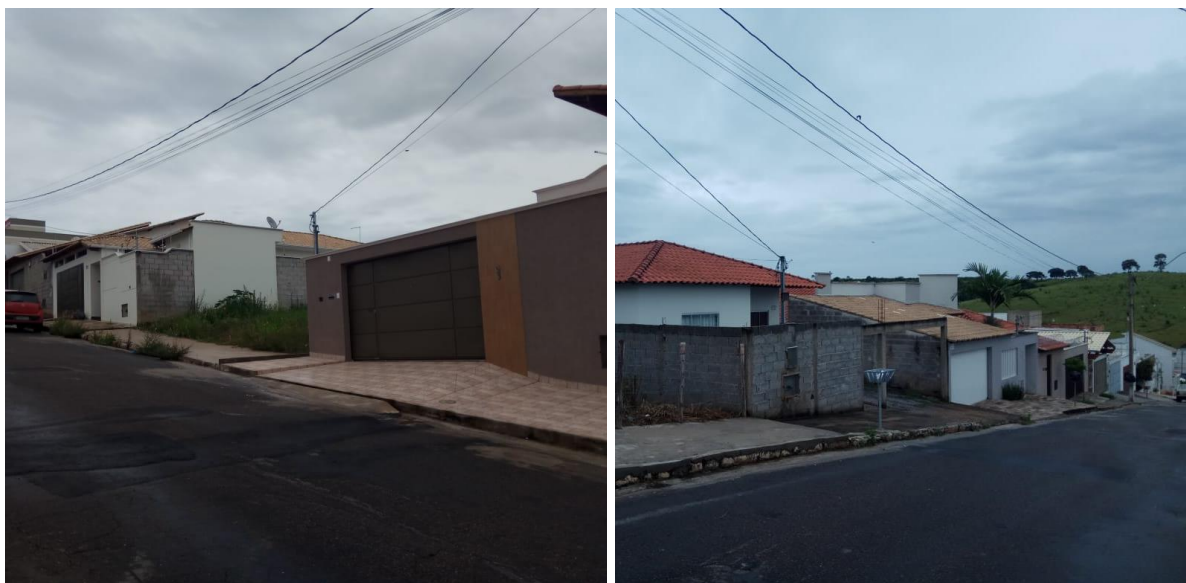
Figura 6 - Residências vizinhas ao lote no mesmo lado da calçada
