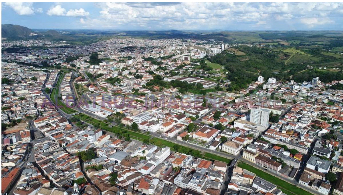
Figura 65 – Vista aérea do Córrego do Lenheiro e do centro histórico de São João del-Rei.
