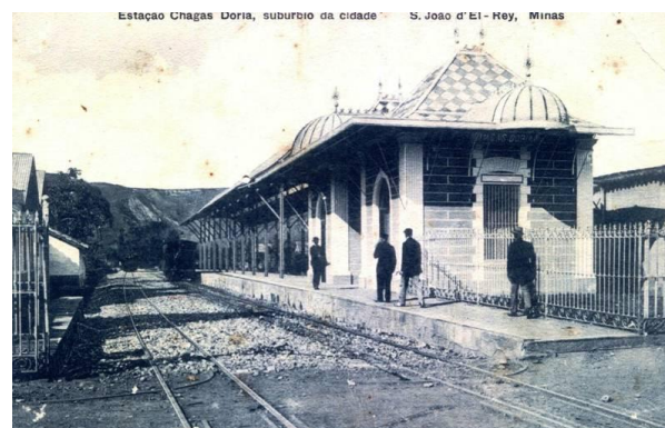
Figura 36 - Estação Ferroviária de Chagas Dória.
