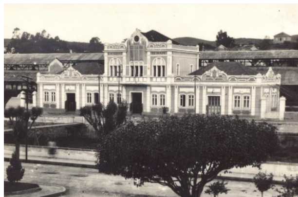
Figura 32 – Vista frontal da Estação Ferroviária de São João del-Rei (depois da ampliação e alteração parcial da fachada).
