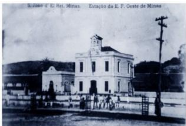
Figura 31 – Vista frontal da Estação Ferroviária de São João del-Rei (antes da ampliação e alteração parcial da fachada).
