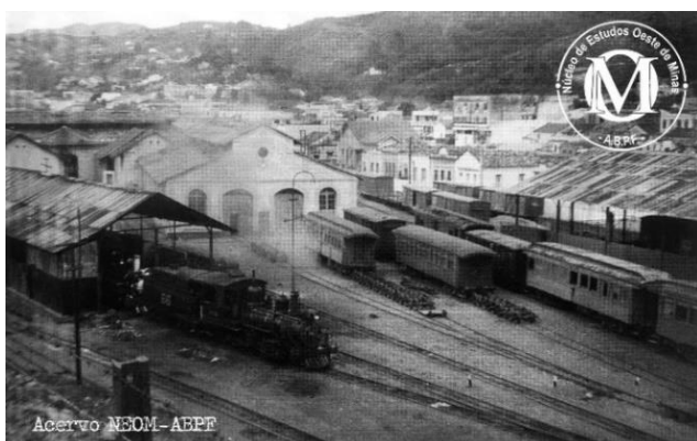
Figura 33 – Pátio de operação com oficina das locomotivas e galpão de oficinas.
