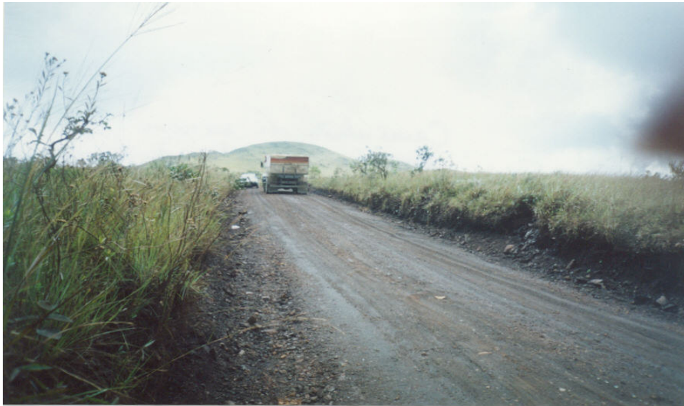
FIGURA 5.14. Transito de veículos carregados de minério dentro do Parque.
