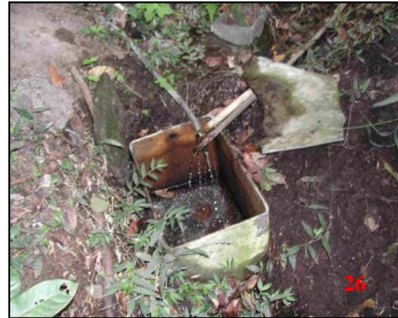
Figura 25: Captação de água de nascente cerca de 50,0 m a jusante do ponto de monitoramento VSM03, Bacia Hidrográfica do Córrego Água Santa.
