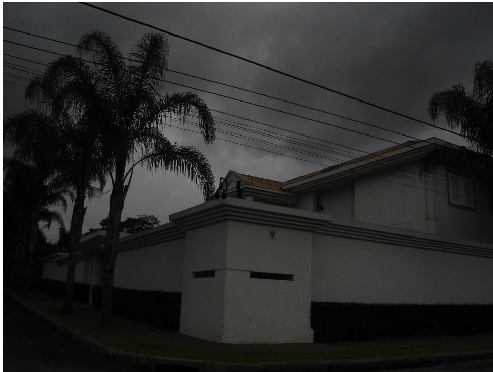
Foto 5 - Guarita em uma casa do Belvedere II
