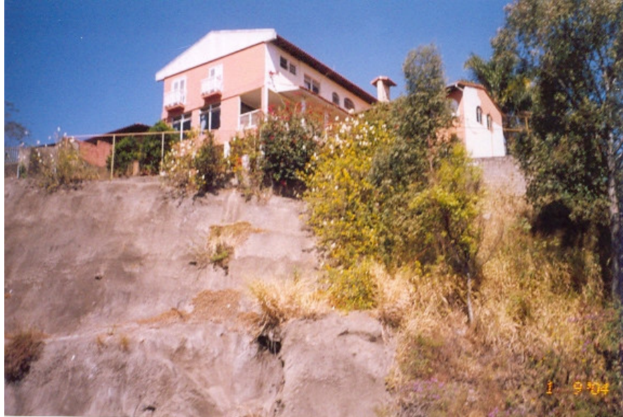
Foto 2 - Casa no Belvedere I, próximo à Avenida Nossa do Carmo. Praticamente todas as casas nesta faixa de terreno possuem muro de arrimo desta envergadura
