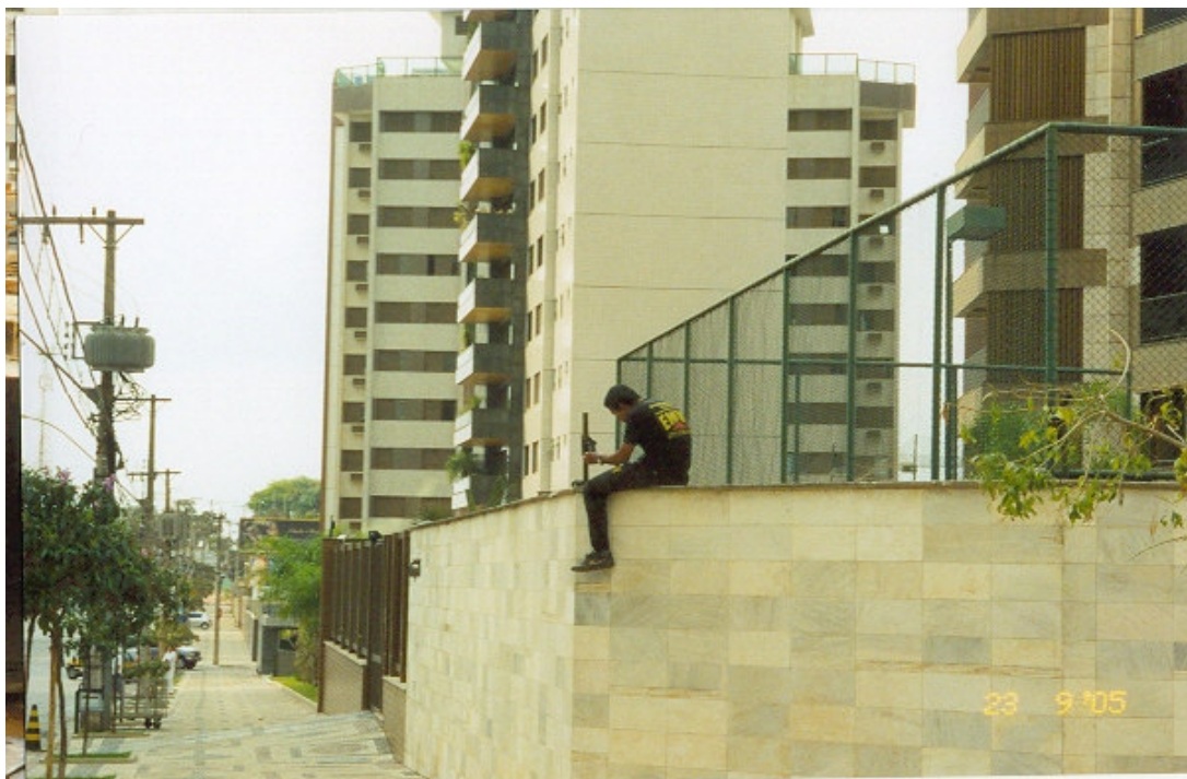
Foto 9 - Funcionário da EMIVE instalando cerca elétrica em edifício do Belvedere III
