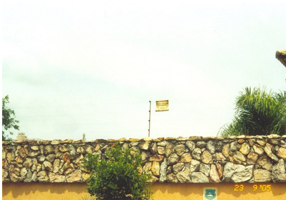
Foto 8 - Casa do Belvedere II cuja construção demonstra a preocupação com segurança. Além de muro elevado, há também cerca elétrica
