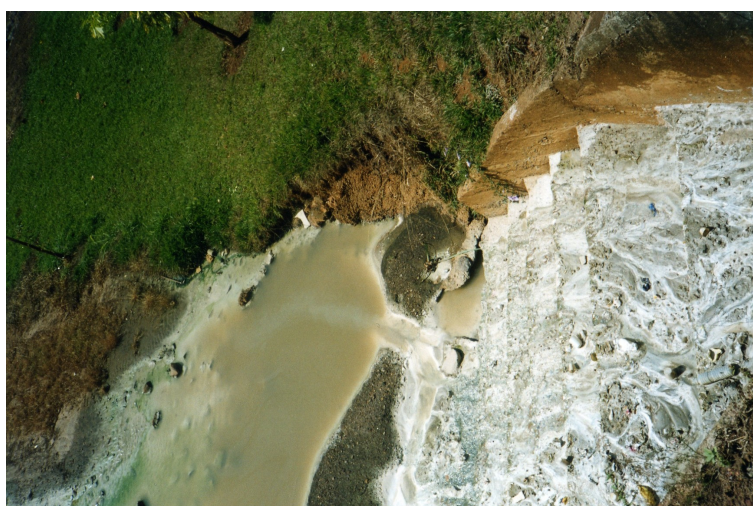
Foto 29 - funções da Lagoa Seca: caminhada e exercícios e conduzir o esgoto do bairro
