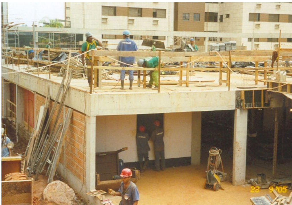
Foto 18 - Trabalhadores em canteiro de obras do edifício Beau Rivage , da construtora Caparaó
