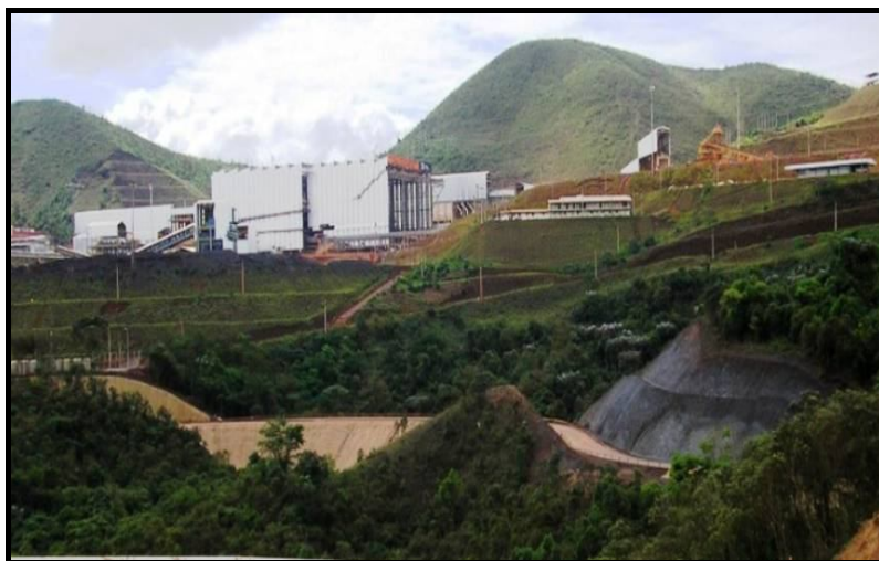
FIGURA 6: Usina de beneficiamento da CVRD na mina de Brucutu, localizada na Serra do Tamanduá, considerada como a maior mina do mundo em fase inicial de produção.
