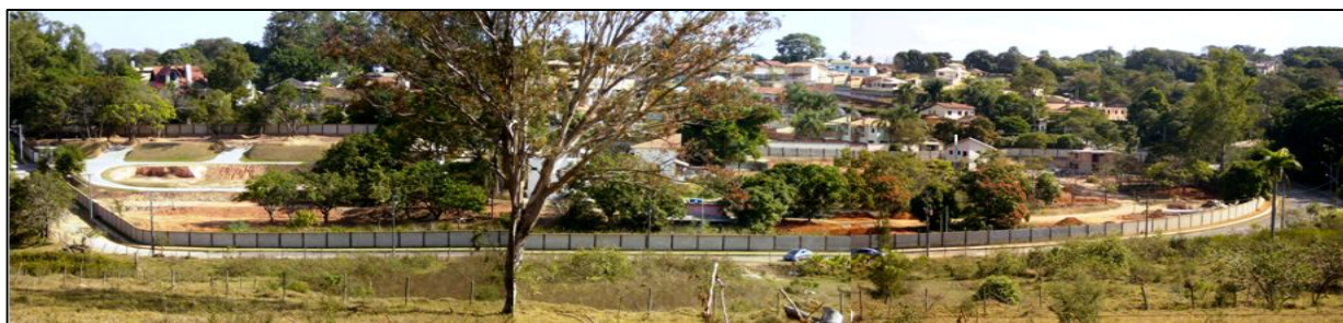
Fotografia 2.8: Área de construção do condomínio Jardins de Istambul ainda em início de construção.
