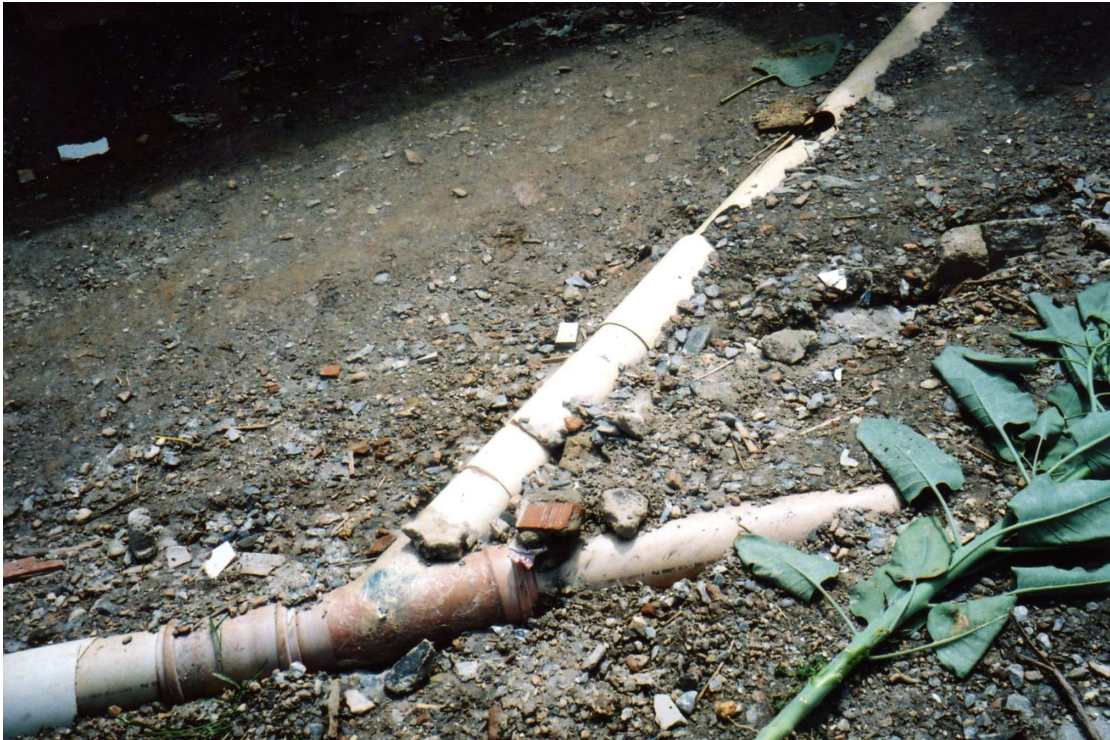
Foto 22: Esgoto danificado feito por habitante. Rua Monte Carvalho setor 11. Fonte: arquivo do autor, 2007.
