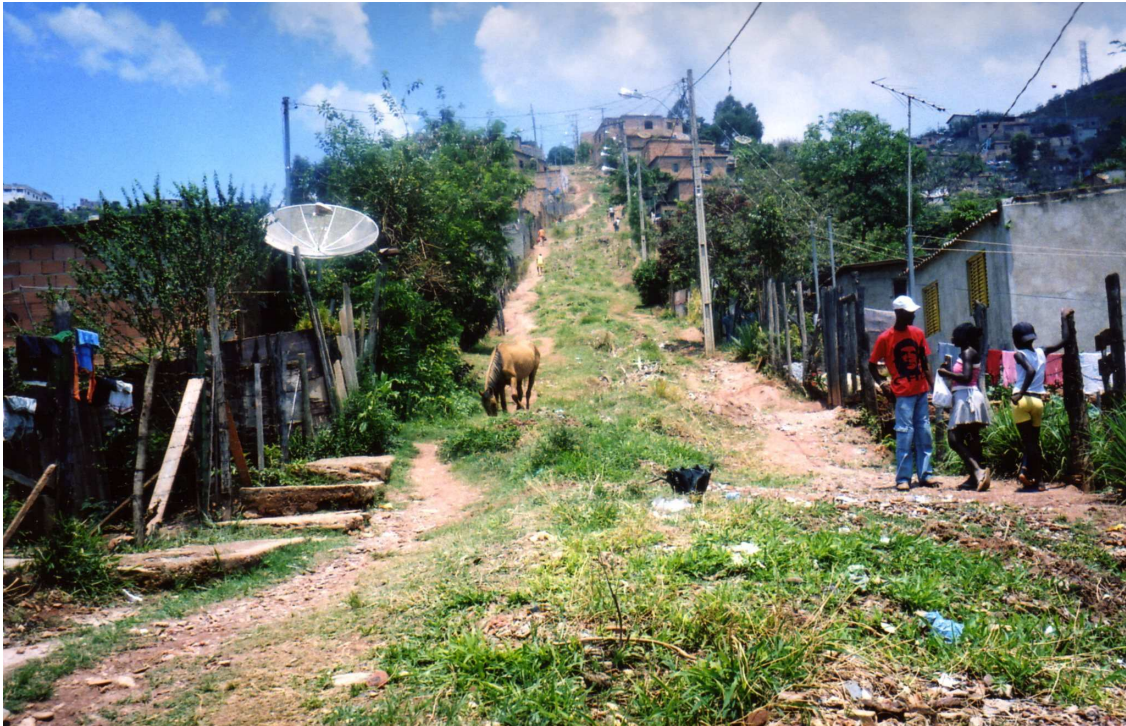
Foto 33: Parte da Rua Arco Íris, perpendicular à curva de nível, setor 12. Reparar a extensão da via até o habitante alcançar o asfalto.
