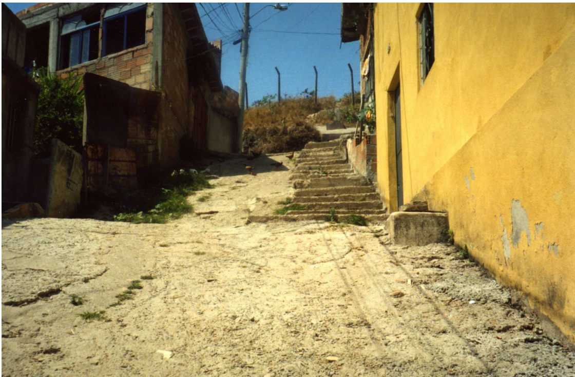
Foto 20: Capa de concreto feita pelos moradores para facilitar o acesso às residências. Rua Castelo Branco, setor 10. Fonte: arquivo do autor: 2007.
