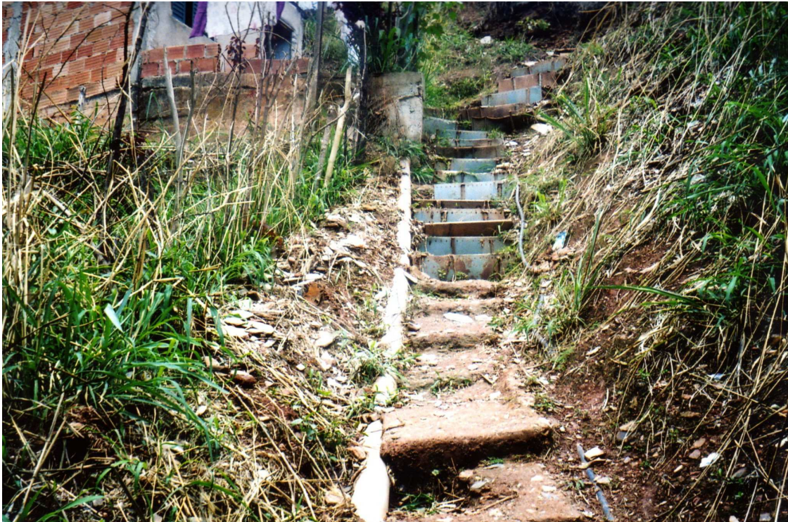
Foto 21: Escada feita por morador em movimentada trilha no setor 12. Observar, à esquerda, encanamento de esgoto feito pelo mesmo habitante que improvisou a escada.
