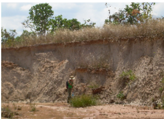
FIGURA 115 – No barranco, do lado direito da voçoroca de cabeceira que erodiu a zona da borda da vereda dos Paulistas, marca de deslizamento de terra do tipo rotacional, o que evidencia o recuo ativo da voçoroca. (out./2006).
