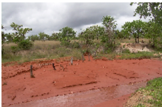
FIGURA 117 – Zona da borda da vereda dos Paulistas, erodida e assoreada por sedimentos cuja área fonte é de Neossolo Quartzarênico da voçoroca lateral na zona do envoltório. No primeiro plano, canal de escoamento de água da voçoroca da cabeceira da vereda. Ao fundo, o cerrado da zona do envoltório. Buritizeiro. (out./2006).
