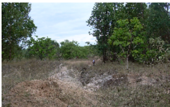
FIGURA 151 – Sulcos de erosão e monte de colúvio no lado direito da cabeceira da vereda do Meloso, devido a enxurradas que passam pelo tubulão de drenagem sob a rodovia BR-365 e daqueles que descem da estrada paralela à rodovia entre esta e o eucaliptal. (out./2006). Em setembro de 2007, a área de sulcos de erosão foi transformada numa barraginha para que o escoamento
