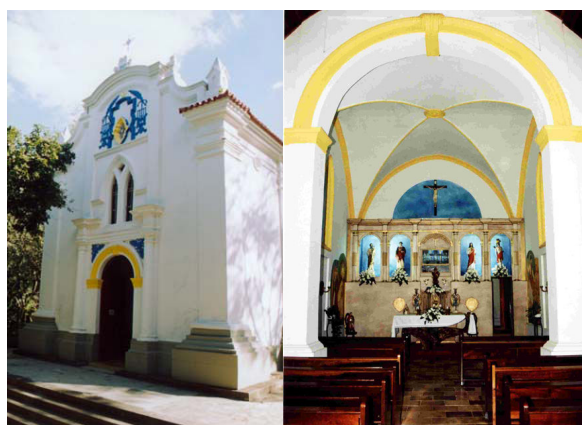
Figura 19 – Ermida de Bom Jesus do Monte Fonte: Acervo da Casa da Cultura de São Lourenço
