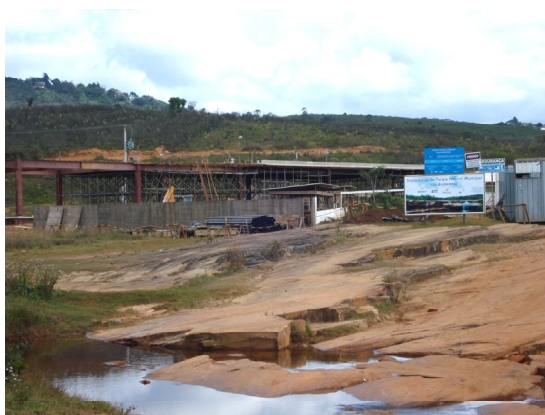
Figura 38 – Foto das obras de infra-estrutura do Parque. Fonte: Raquel Scalco, 2008.
