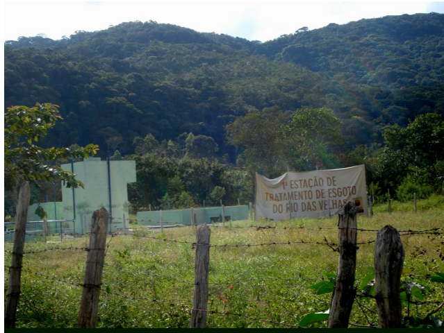
Figura 57 – Foto do local onde está sendo implantada a 1ª ETE do Rio das Velhas – Distrito de São Bartolomeu.
