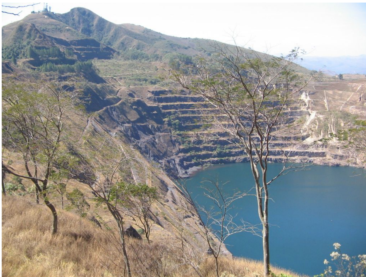
Figura 32: Área de mineração desativada na região da Serra do Curral
