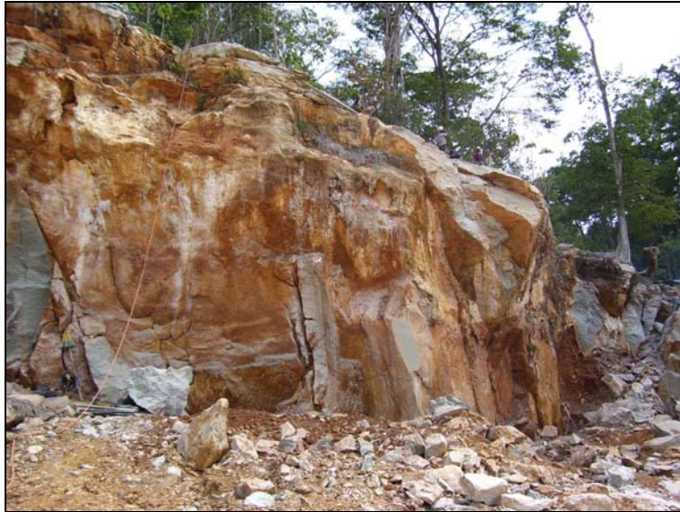
FIGURA 23. Nível intermediário (produtivo) na lavra de calcário Royal Verde. Observa-se o grau de fraturamento com fraturas e diáclases de alto ângulo.
