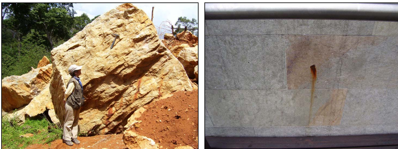
FIGURA 47. Nódulos de ferro (goethita) visíveis tanto no bloco extraído do frente de lava (esquerda) quanto no muro externo do centro de convenções de Medellín (direita).
