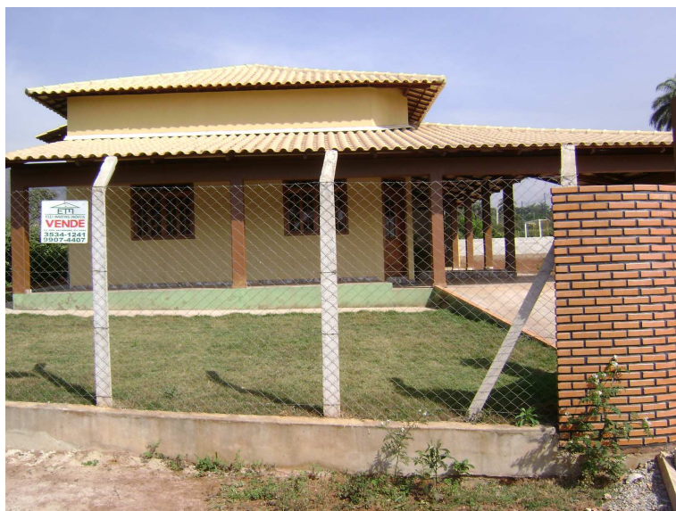
Figura 8 – Imóvel do Residencial Santa Mônica II, Igarapé -MG Fonte: foto da autora, jun.2008
