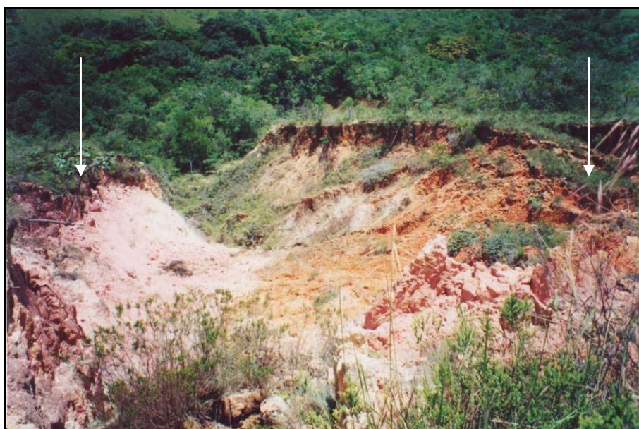
Figura 14: Foto de montante para jusante da voçoroca 2, vertente da margem direita do córrego do Quebra.
