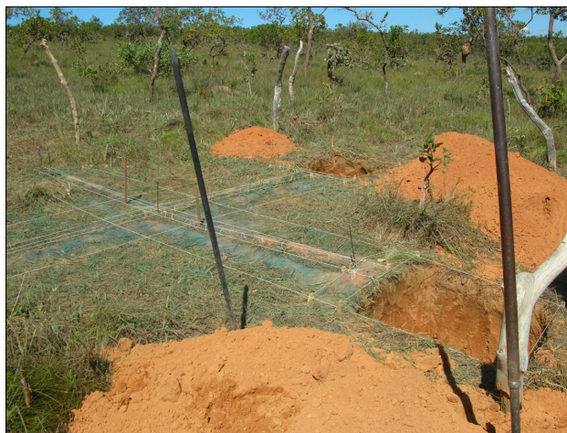
FOTO 4.13 - Início da abertura das trincheiras: perfis A1 e B1
