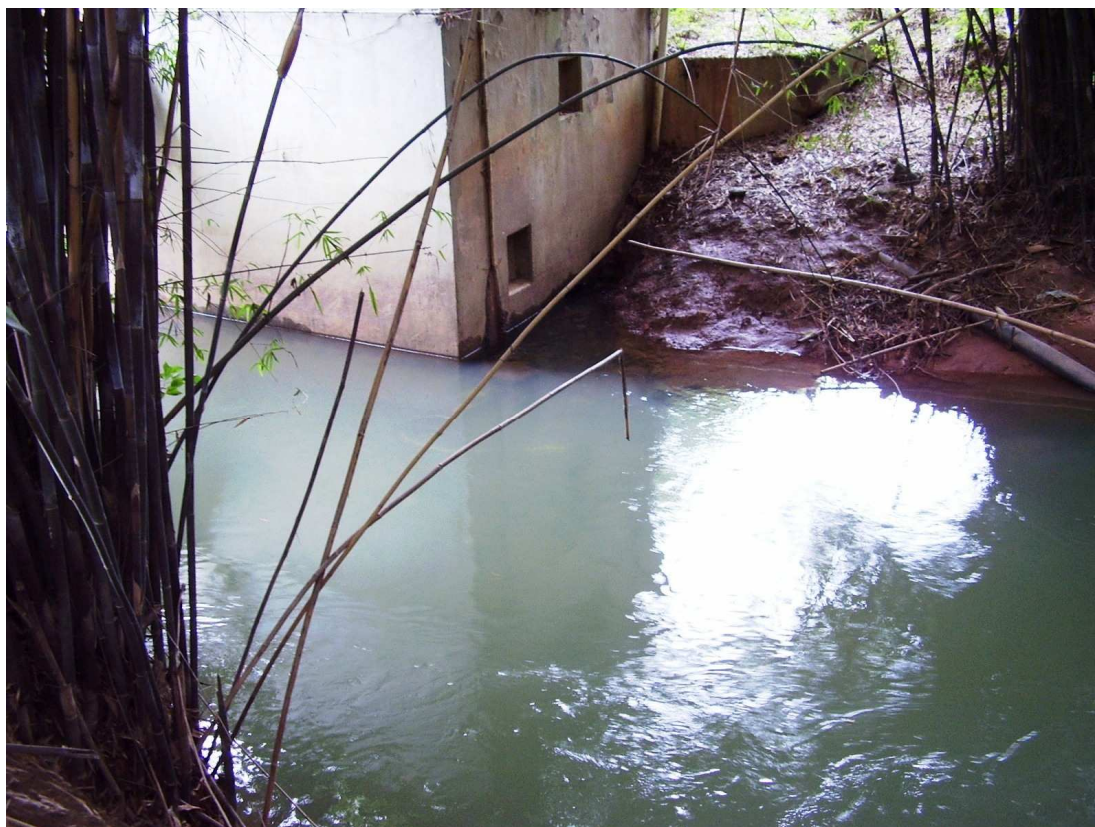
Figura 8: Captação na surgência à margem esquerda do rio São Miguel.
