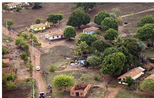
Figura 30: Vista das casas do vilarejo de Caraíbas, atingidas pelo terremoto. Osvaldo Afonso/Secom/Governo de MG, dez 2007, cedida por Ronaldo Sarmento.
