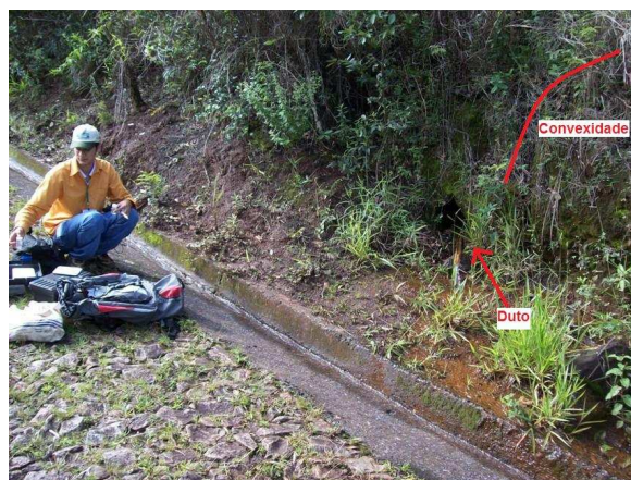
FIGURA 102 – Nascente em duto em talude de corte de estrada, com convexidade a montante (N017). Foto: Miguel F. Felipe.
