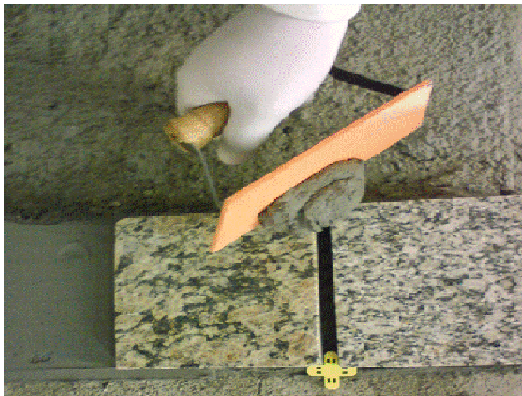
Figura 85-Aplicação do rejuntamento.
