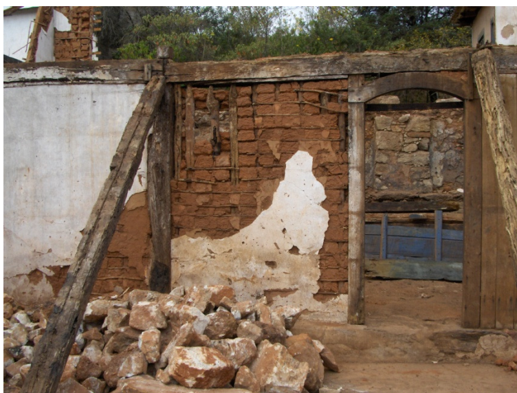
Figura 77-Exemplo de construção utilizando a técnica de pau a pique em Lobo Leite – MG.
