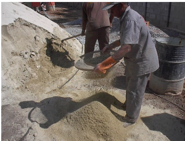
Figura 110-Peneiramento da areia para argamassa tradicional.
