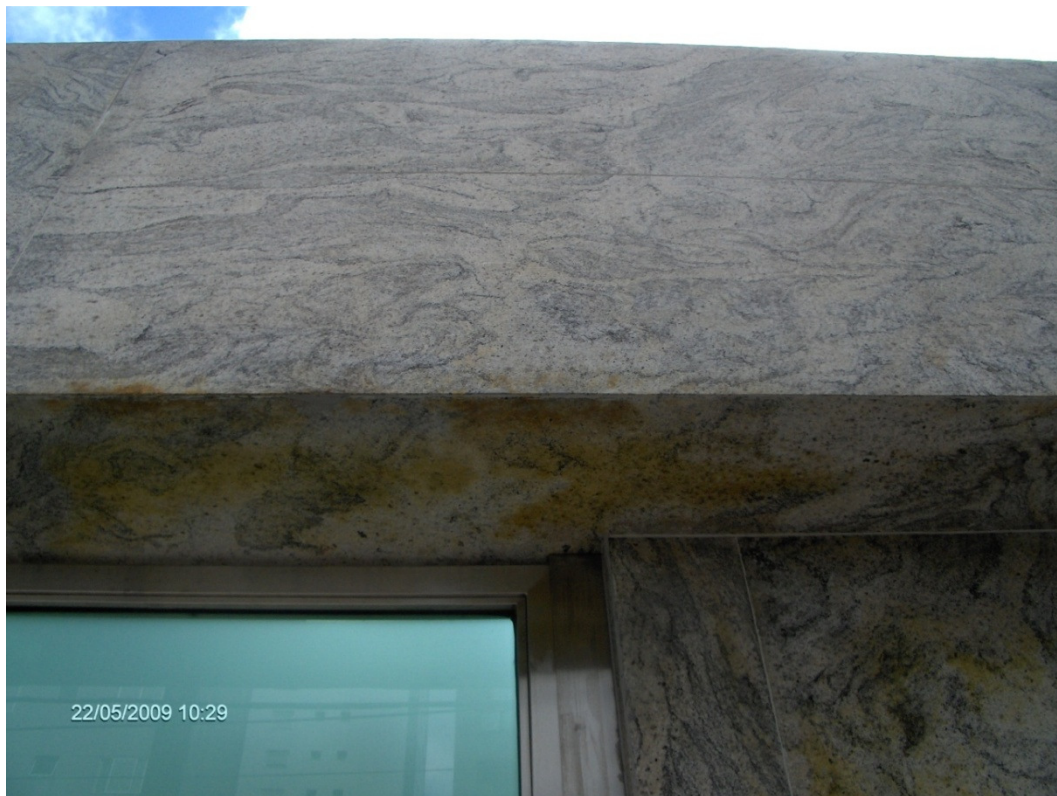
Figura 23-Mancha de ferrugem causada pela decomposição de minerais ferríferos.
