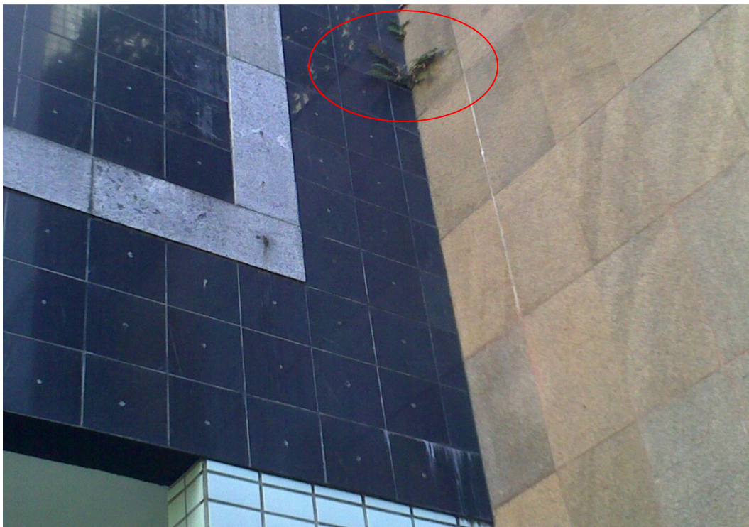
Figura 57-Desenvolvimento de plantas em nichos do rejuntamento.
