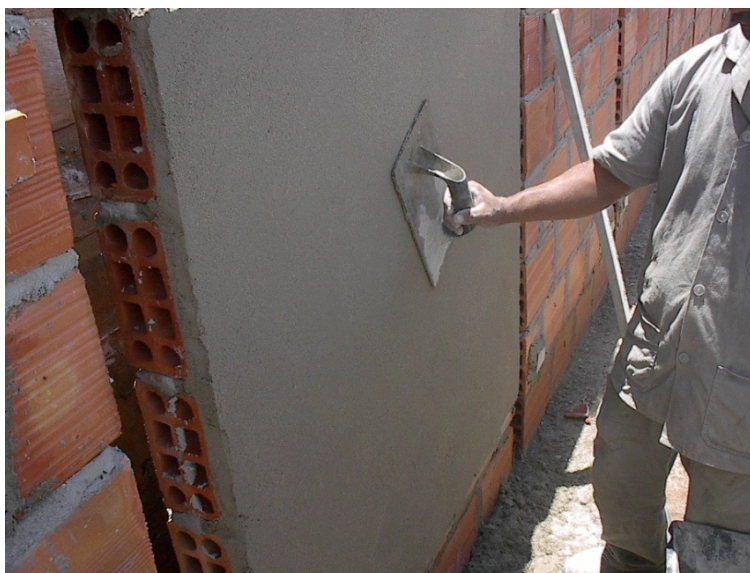
Figura 111-Desempenamento do emboço.
