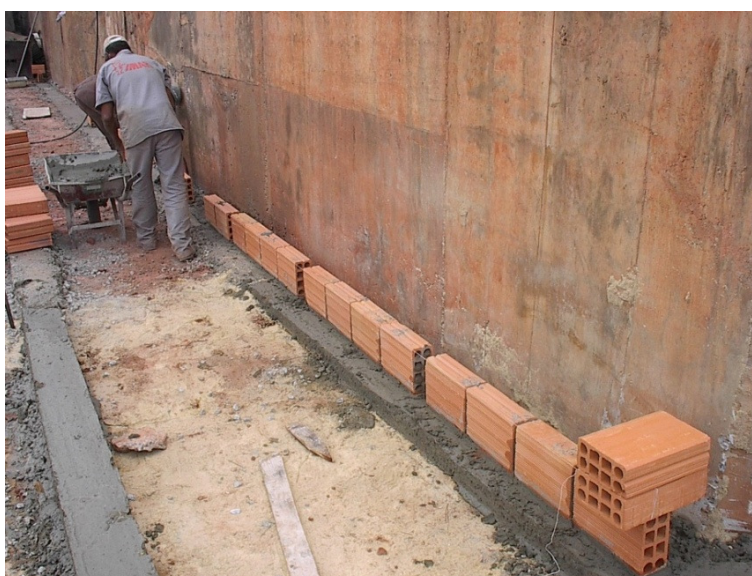
Figura 108-Execução dos painéis de teste.
