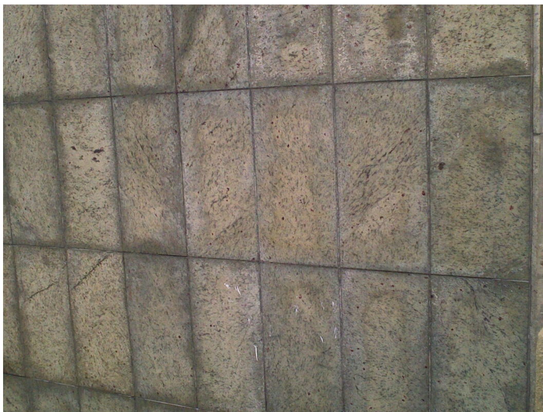
Figura 15-Modificação generalizada de cor. Algumas diferenças já vêm da pedra e são realçadas com a aplicação.
