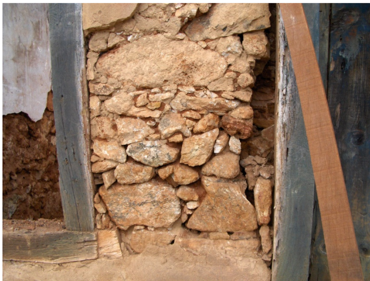
Figura 78-Alvenaria confeccionada com argamassa de barro para alvenaria em uma construção em Itatiaia-MG.
