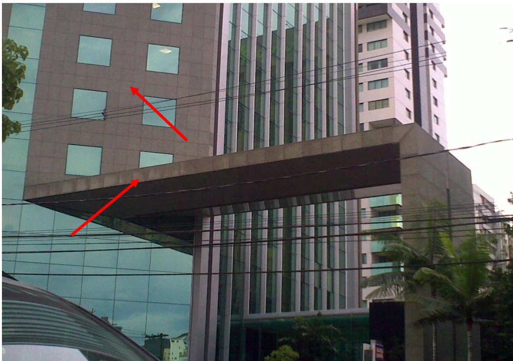
Figura 58-Uso da mesma rocha em condições de assentamento diferenciadas não apresenta o mesmo desempenho.
