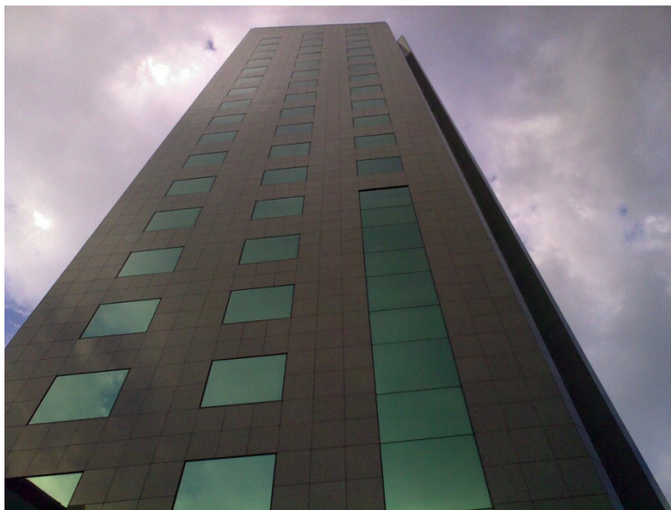
Figura 64-Aspecto final de uma fachada aerada.
