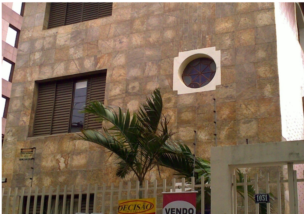
Figura 16-Granito amarelo em acelerado processo de alteração com perda de cor.
