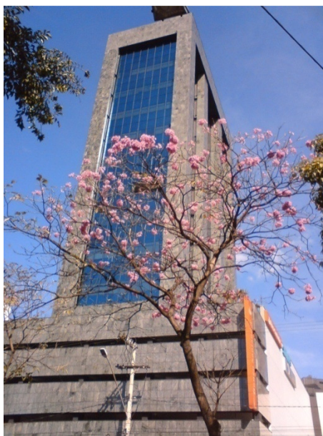
Figura 2-Edifício de múltiplos andares em Belo Horizonte com fachada revestida com granito verde.
