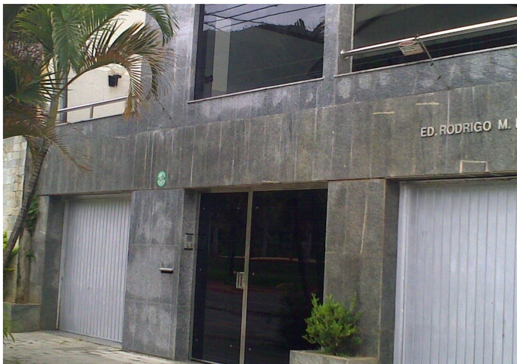
Figura 45-Eflorescências generalizadas.
