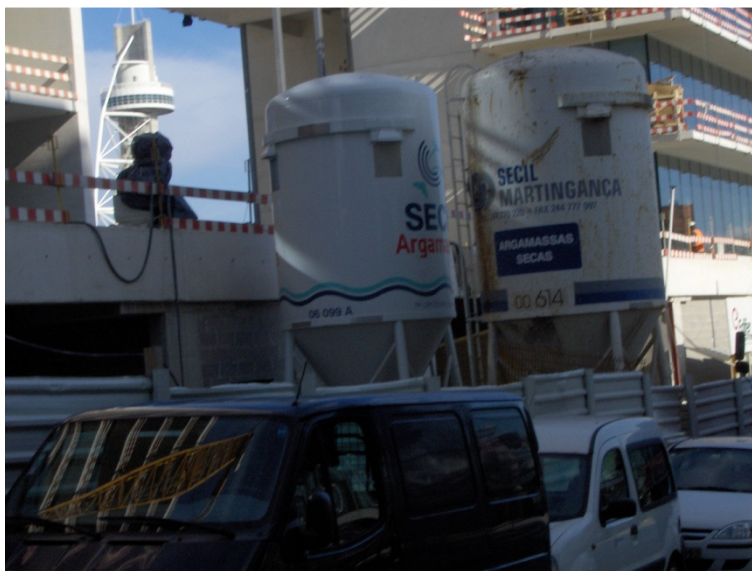
Figura 79-Silos de fornecimento de argamassa no estado anidro.
