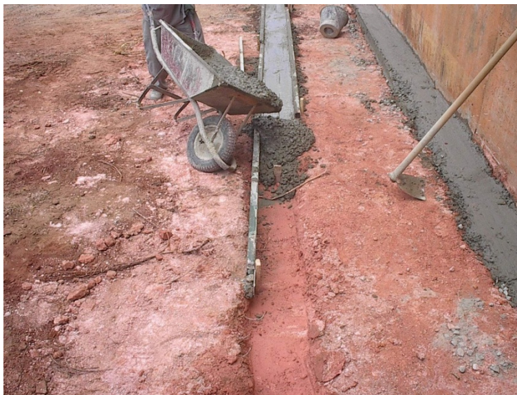
Figura 107-Execução das cintas de concreto para suporte aos painéis de alvenaria.
