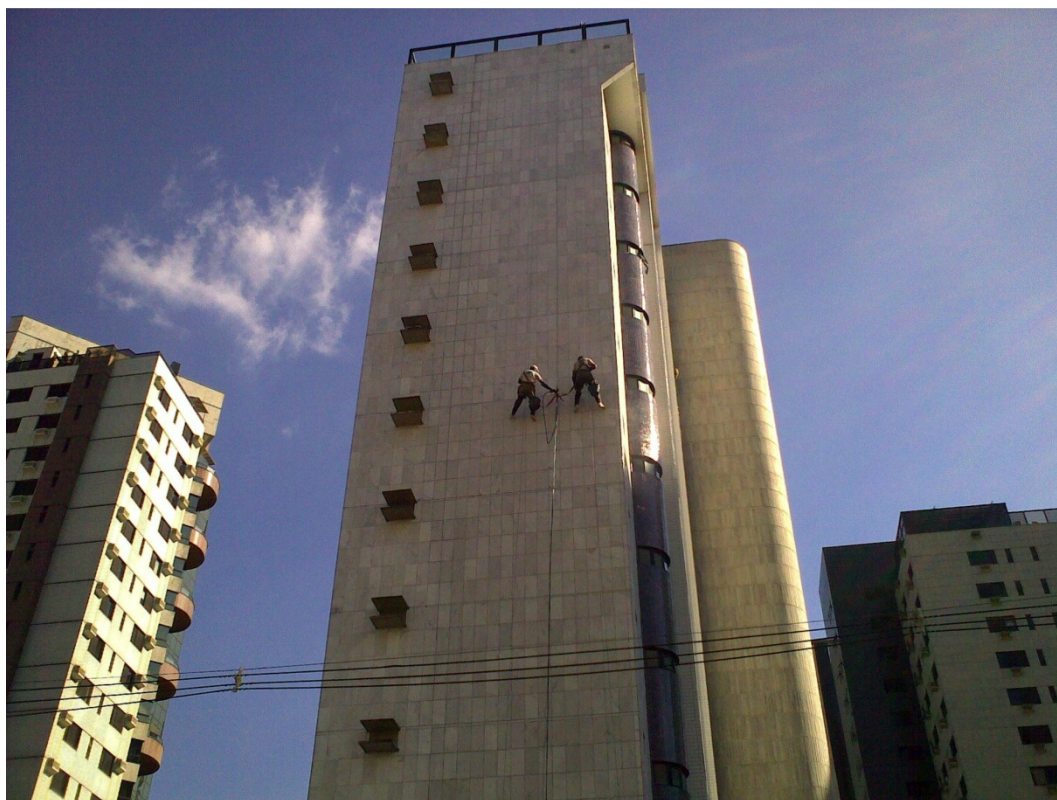
Figura 76-Manutenção em fachada de mármore branco.
