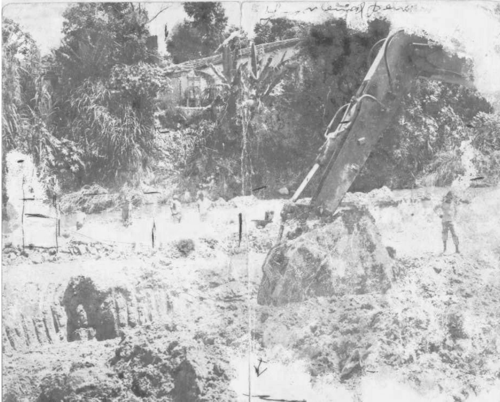
FIGURA 3: Umas das primeiras casas construídas na Vila São Paulo (ao fundo) e uma máquina de extração de areia.
