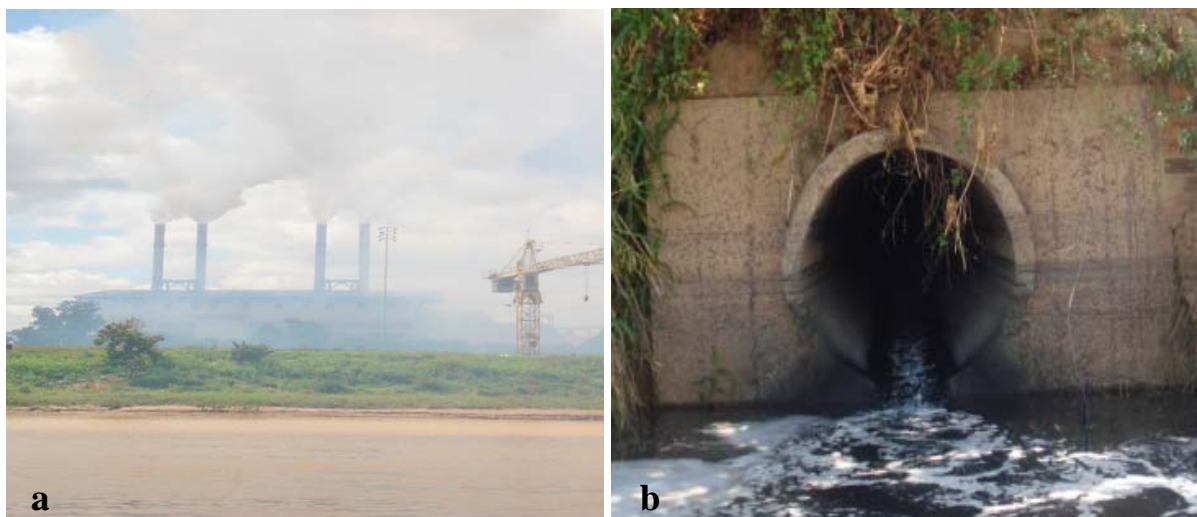
Figuras 3 – Poluentes atmosféricos e lançamento de efluente industrial (Pirapora–MG). a) Liberação de poeira amorfa-cristalina de \text{SiO}_2 , Si e \text{Fe}_3\text{O}_4 , que se depositam no entorno das fabricas e diretamente no rio. b) Lançamento de efluentes residuais das atividades têxtis.
