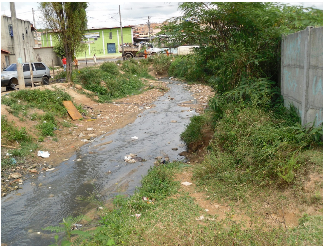
Foto No. 19- Ponto de coleta de amostra de água - PV045.
