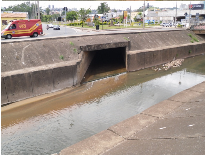
Foto No. 28 - Ponto de coleta PV080 e urbanização.
