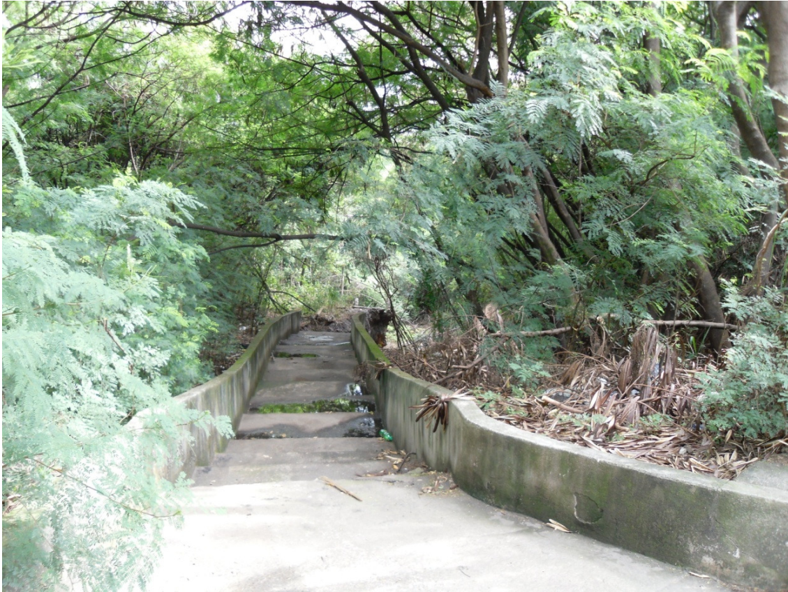
Foto No. 1 - PV005 ponto de coleta de amostra de água.
