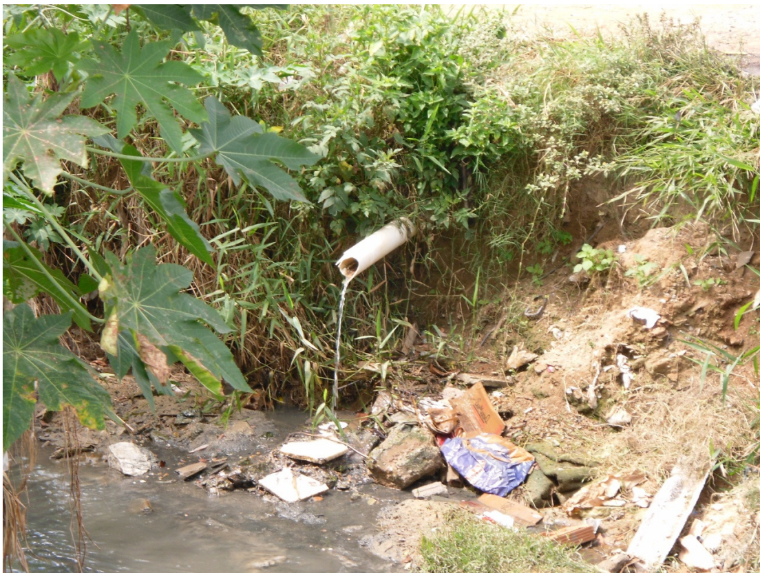
Foto No. 21 - Lançamento de esgotos domésticos no PV045.
