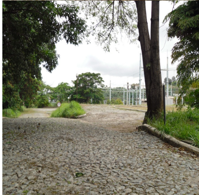
Foto No. 11 – Sub-estação da CEMIG Localizada próxima ao PV015.
