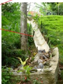
Dissipador de energia da drenagem pluvial.
