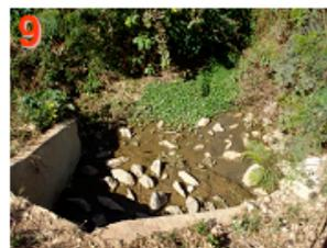
Rede de drenagem pluvial: dissipador de energia em pedras.
