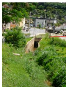
Trecho final do córrego da Av. Baleares: cerca de 80 m canalizados com revestimento fechado.
