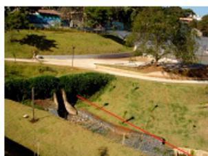
Vertedouro de drenagem pluvial.
