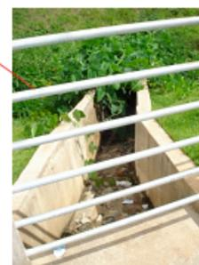
Dissipador de energia da drenagem pluvial.
