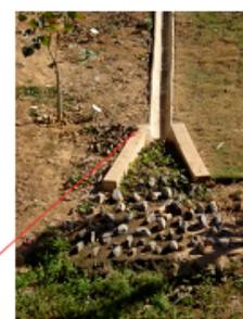
Dissipador de energia da drenagem pluvial.
