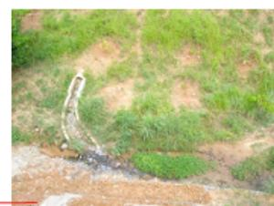
Dissipador de energia da drenagem pluvial.
