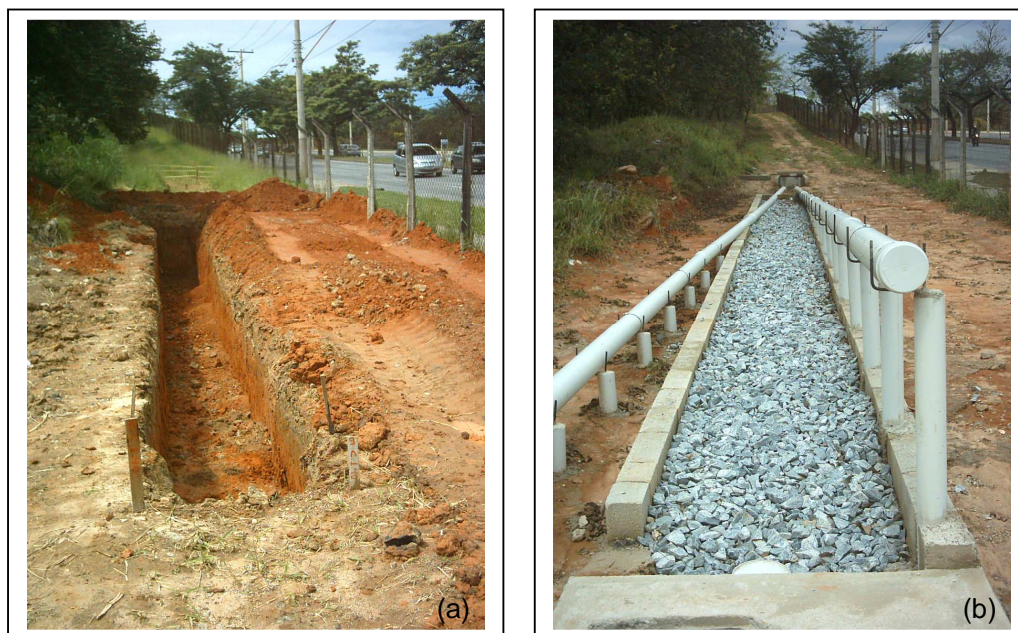
FIGURA 8 – Fotos da trincheira de infiltração implantada na Estação Ecológica da UFMG. (a) sem revestimento, (b) com revestimento de manta geotêxtil e brita.
