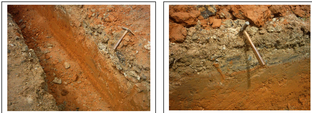
FIGURA 16 - Solo da área de estudo na área de localização da trincheira de infiltração. Cambissolo aterrado por uma camada de material grosso (composta por resíduos de asfalto, brita, cimento, etc.) de aproximadamente 25 cm de espessura.
