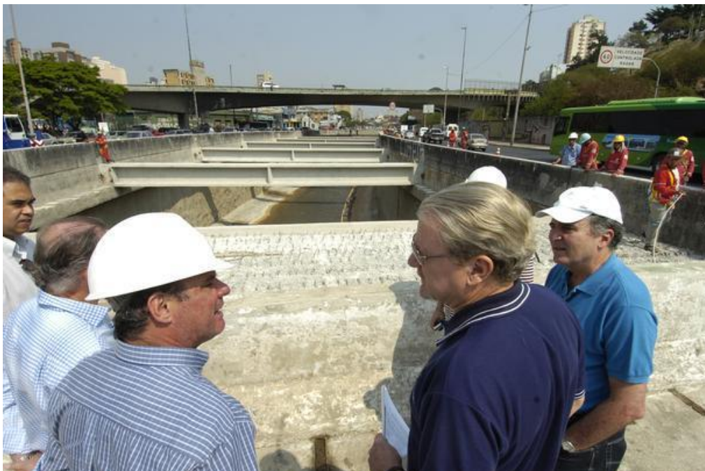
Foto 30: Extensão do novo início do Boulevard Arrudas, entre a Alameda Ezequiel Dias e a Avenida Mem de Sá. Fonte: “Informações Básicas sobre a Linha Verde”.
