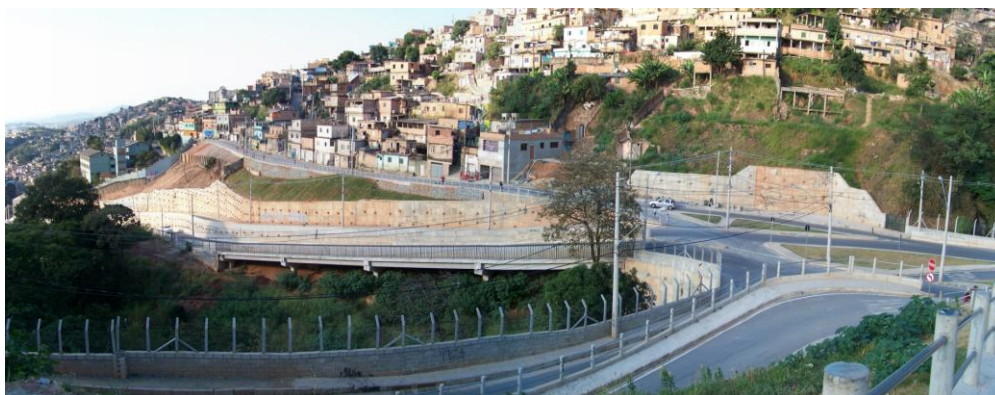
Fotos 25 e 26: Trechos da Avenida do Cardoso, já concluída. Fonte: figura e fotos: URBEL, 2011.
