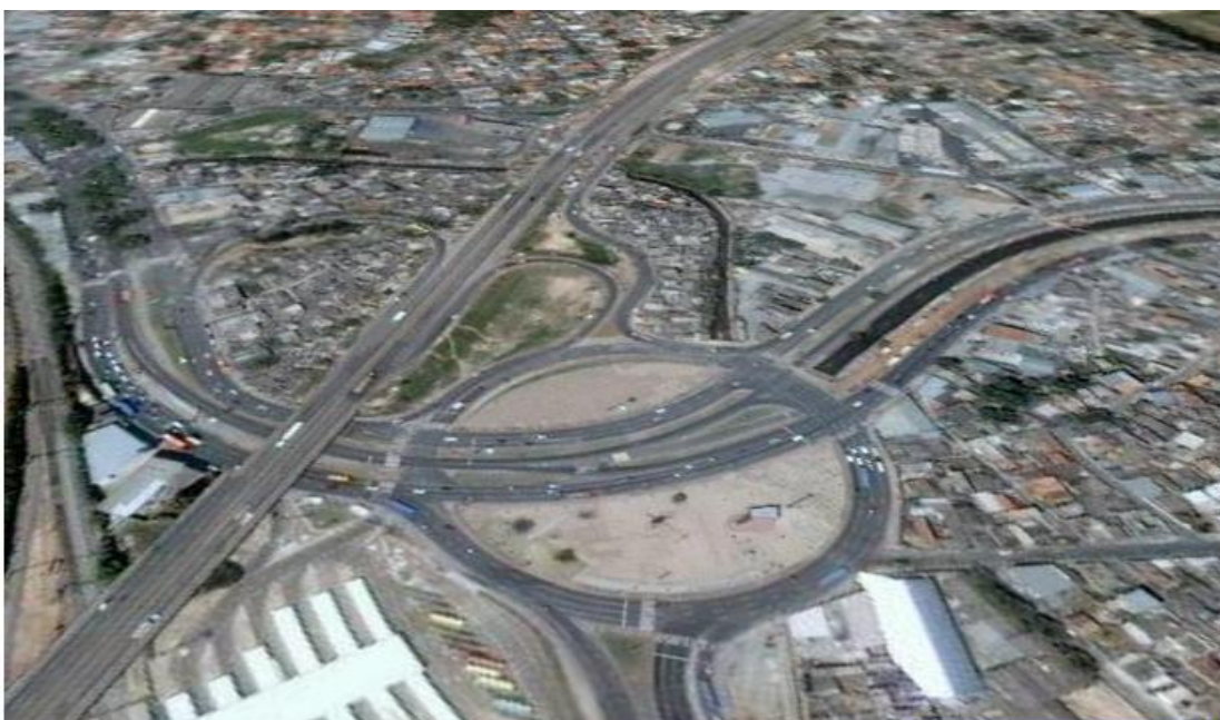
Foto 32: Cruzamento da Avenida Cristiano Machado e com o Anel Rodoviário, anterior à implantação da linha verde. Fonte: “Informações Básicas sobre a Linha Verde”.
