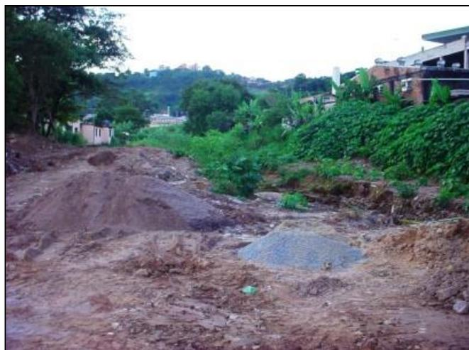
**Figura 23 - Assoreamento no final da Rua Prentice Coelho durante a execução da obra, fevereiro de 2011**
