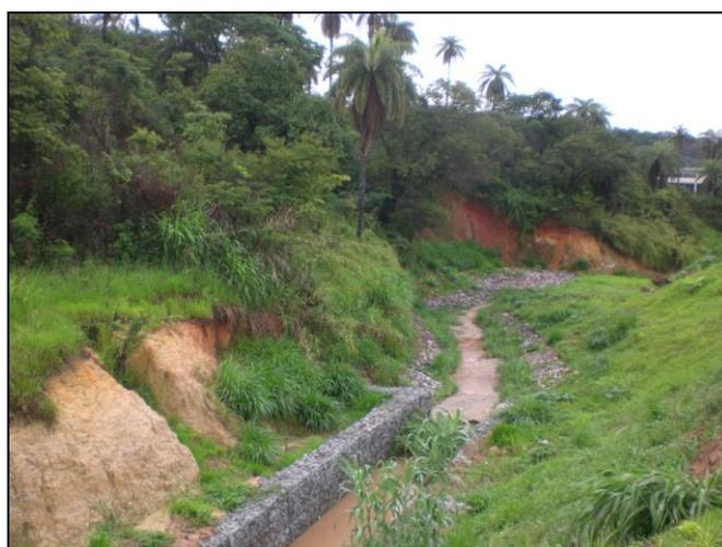
**Figura 22 - Ruptura de talude na margem esquerda do Córrego da Rua Prentice Coelho, dezembro de 2011**
